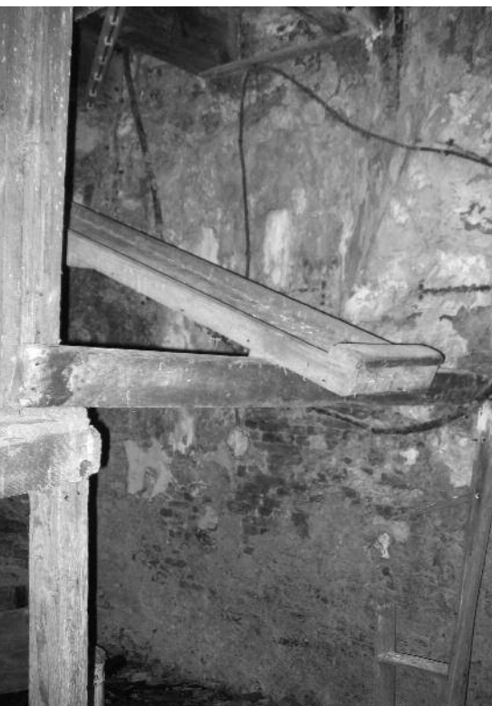
Het einde van de glijgoot onder in de molen vanwaar de zn de maalderij werden ingedragen (foto jsb).
