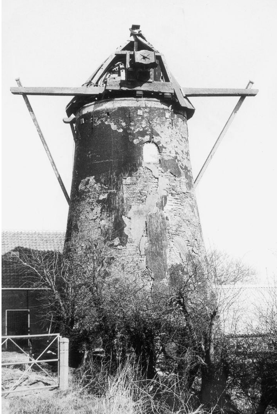
Omstreeks 1970 staat de molen er zo bij. Afgezien van de roeden is alles compleet, maar de situatie is allerbelabberdst (foto C. Bakker).
