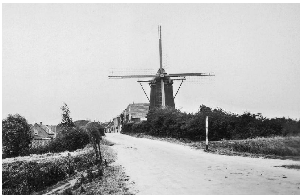
De molen van Ooltgensplaat kort voor de oorlog. Hij is dan al buiten bedrijf. De afgehaalde zeilen en de uitgenomen eindborden illustreren dit.
