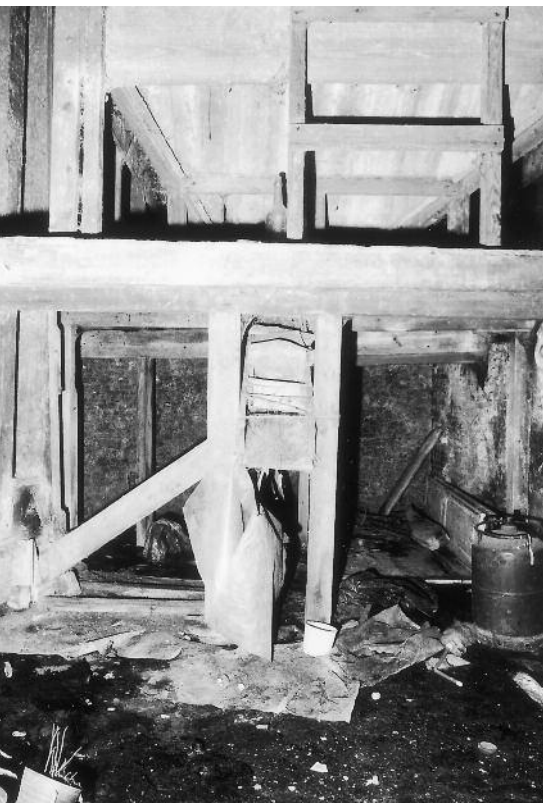
Kaar onder de vloer van de baliezolder met links de koker naar de jacobsladder en vooraan de mogelijkheid tot aftappen (foto J. De Vries).
