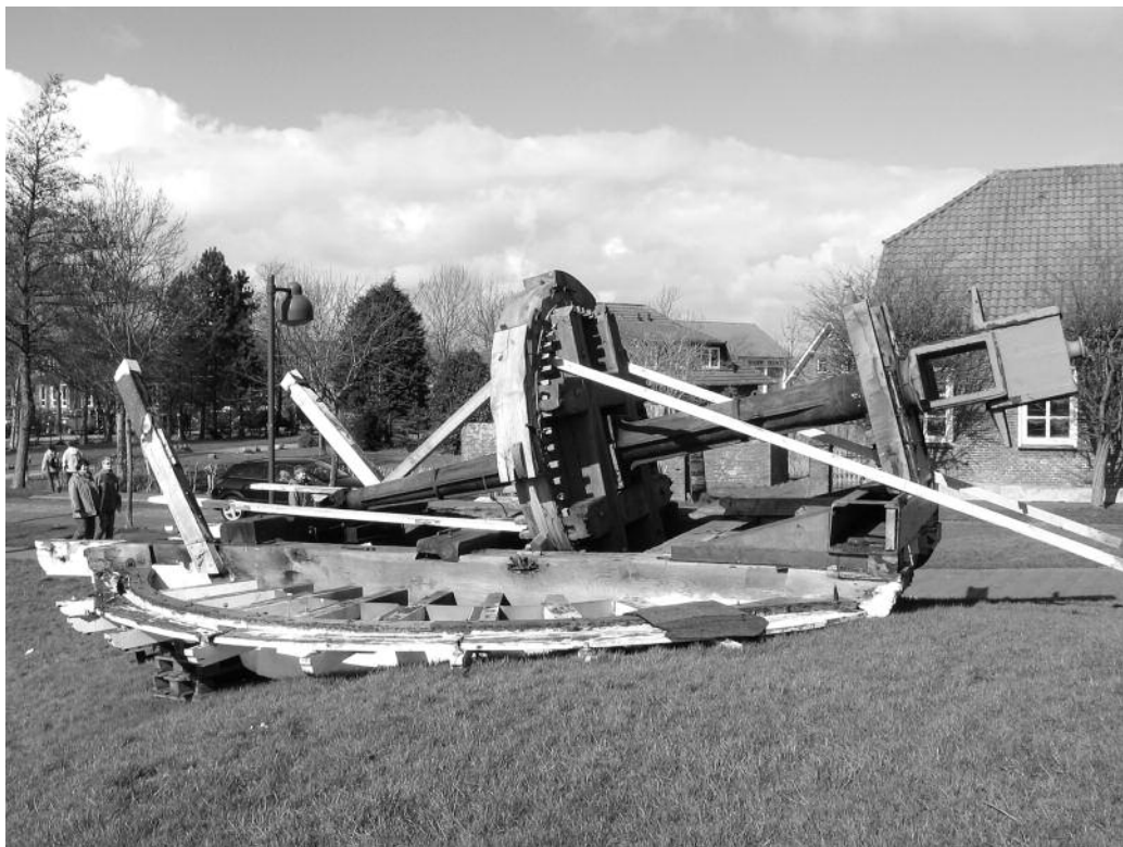
De oude kap van de Westmolen van Greetsiel op de grondnaast de molen. De windpeluwconstructie is naar Nederlandse begrippen merkwaardig (foto David Reitsema, 9 april 2006).
