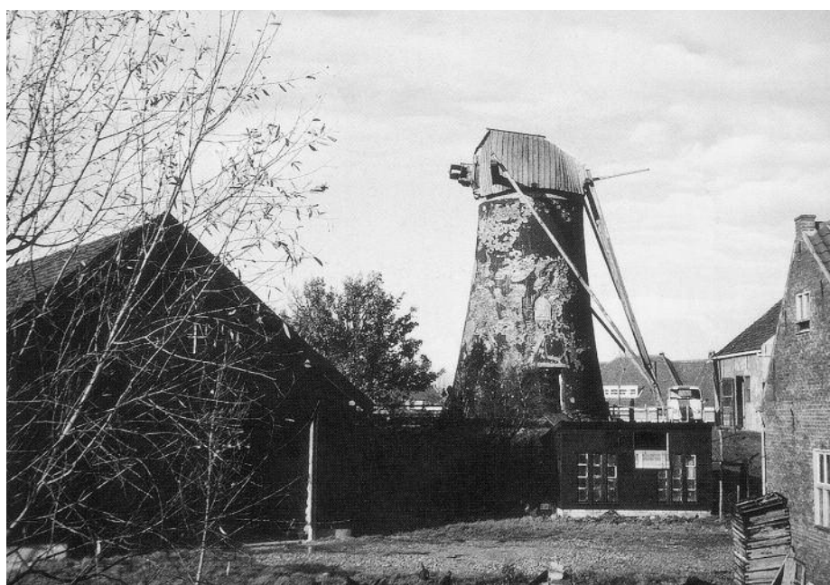
De onttakelde molen in 1960. De romp ziet er afschuwelijk slecht uit, maar de kap lijkt nog redelijk dicht (foto M. van Hoogstraten/Stichting Levende Molens).
