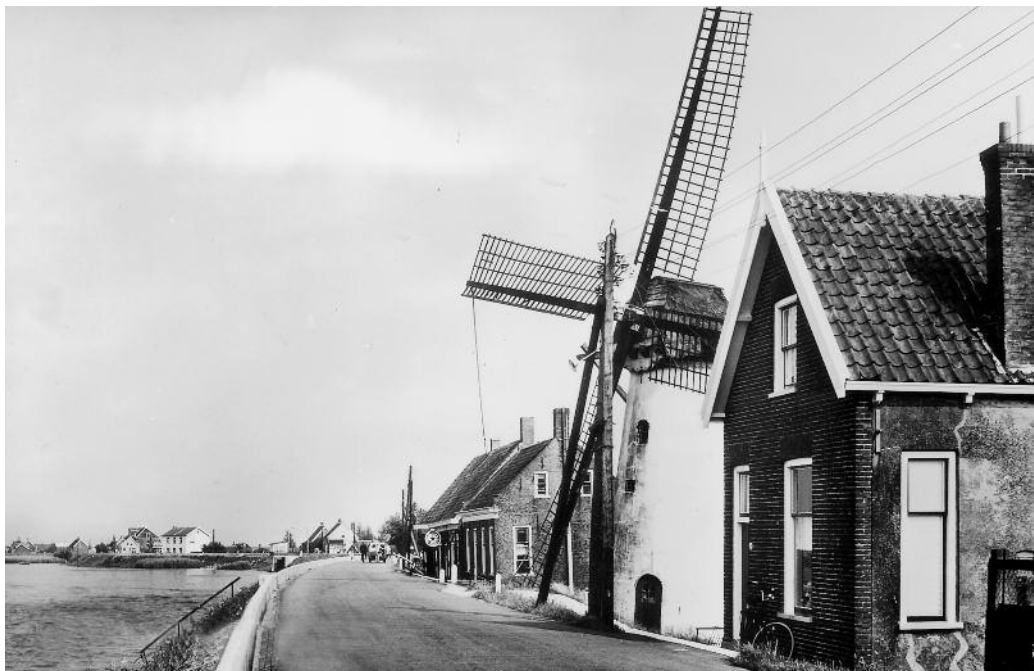
De molen van De Regt omstreeks 1964. Links de na de stormramp van 1953 aangebrachte muur. Ook de leuning van de trap voor het lossen van schuiten is zichtbaar, evenals het gat in de muur met de verbreding voor de vloedplanken. Het zal inderdaad geen pretje zijn geweest om zo een schuit te lossen.
