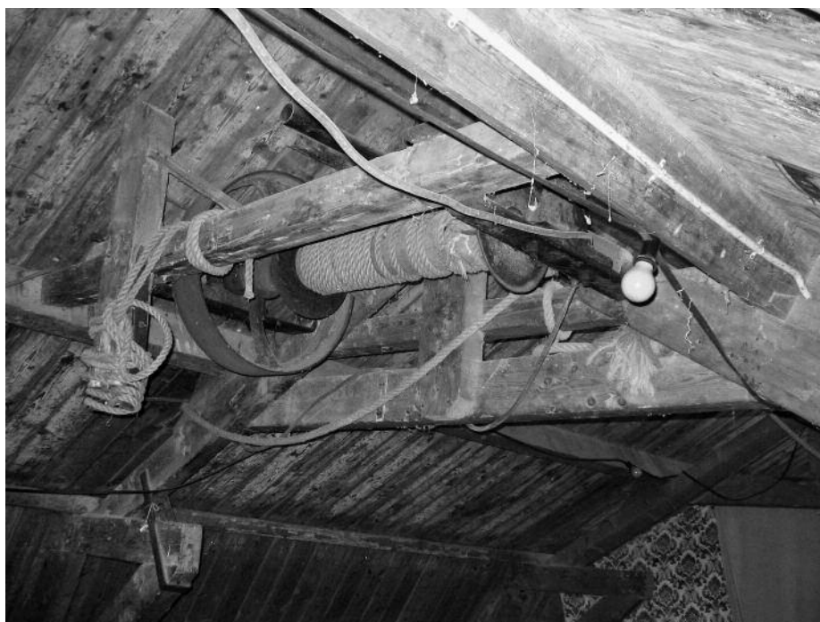
Het luiwerk in de nok van de maalderij (foto jsb).
