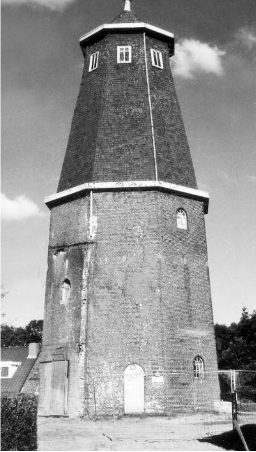
De molen van Hoonhorst na de sloop van de aangebouwde mengvoederfabriek van Fakkert in 2004.
