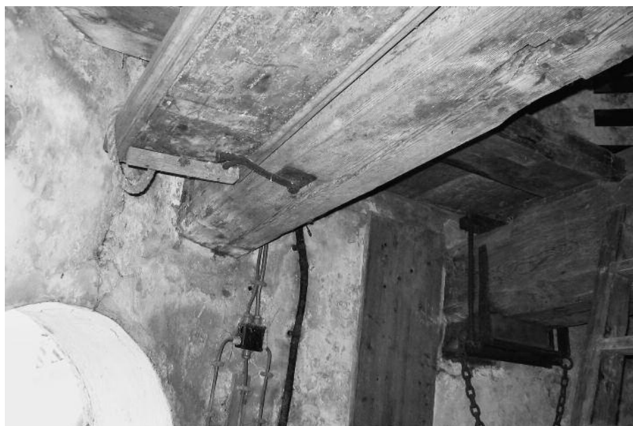
De glijgoot waarlangs zakken van de steenzolder (waarop de maalstoel stond) werden neergelaten op de maalzolder. De goot is een oud vrachtwagenzijbord. De haak ervan doet dienst om de goot te borgen tegen een zolderbalk! (foto jsb).
