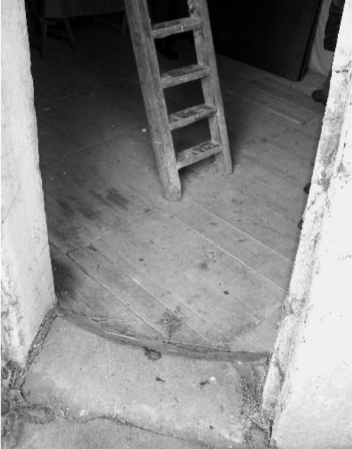
Het luik in de vloer van de maalzolder waardoor zakken werden neergelaten naar de begane grond (foto jsb).
