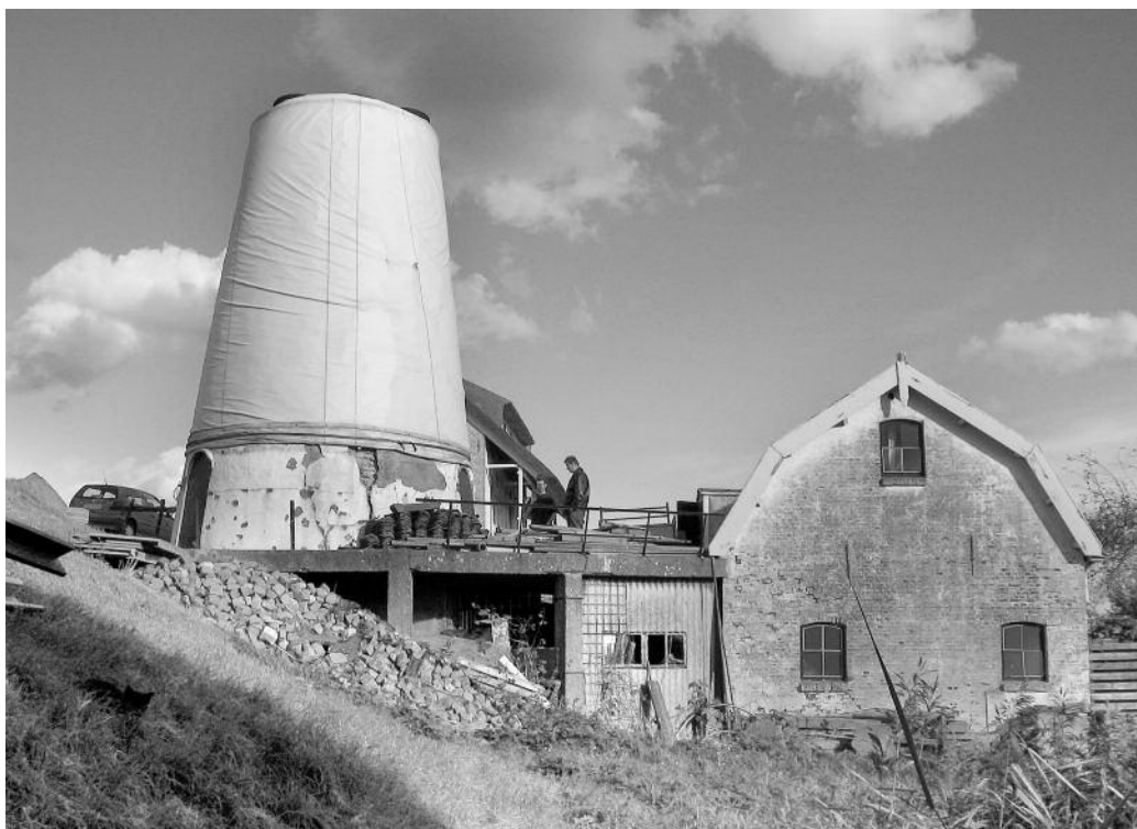
Molen en maalderij in oktober 2004 met ertussen het betondek (foto jsb).
