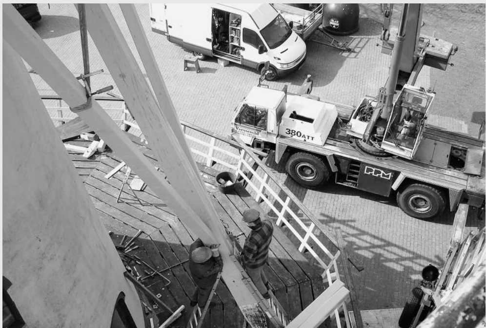
Het aanbrengen van de staart aan de molen van Giesbeek (foto Vaags).
