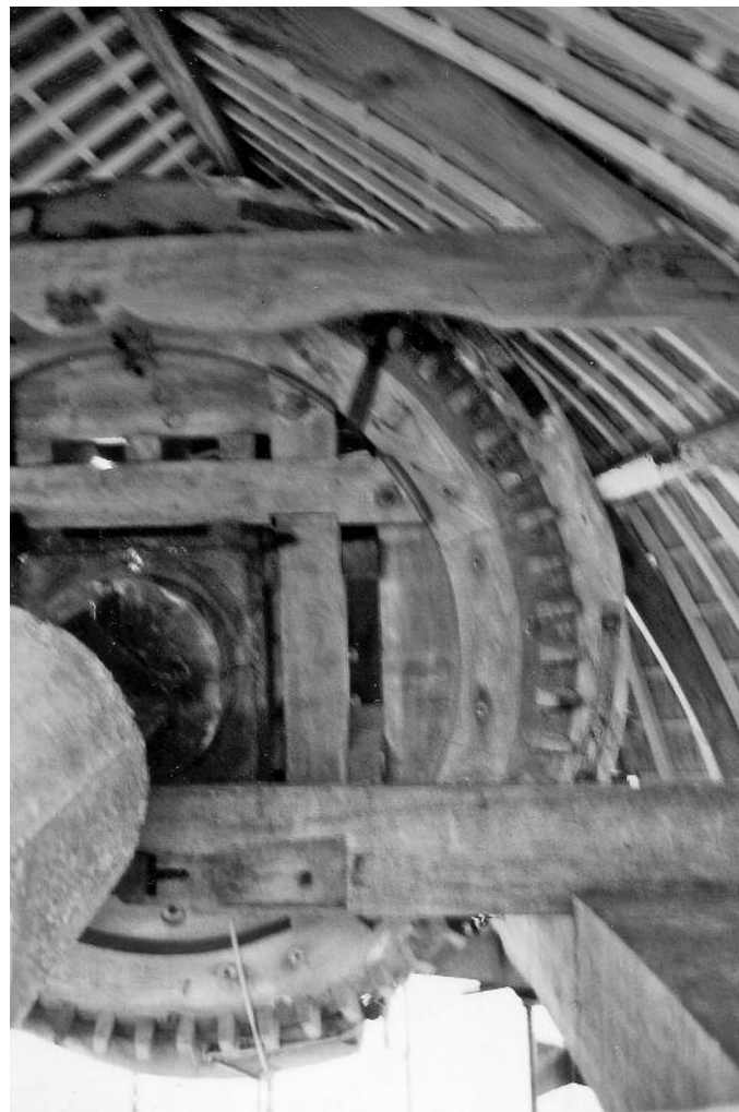
Het bovenwiel met het conisch werk. Links de betonverzwaring op de as.
