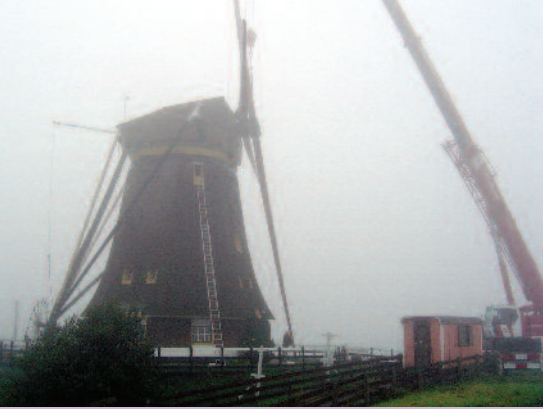
De nieuwe windpeluw krijgt zijn plaats in de foto van de Blauwe Molen (foto Verbij Hoogmade).
