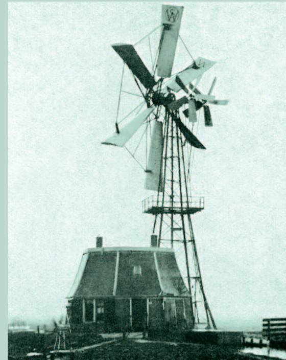
De Agrico-windmotor bij de Gnephoekse Molen; een curieus geheel.
