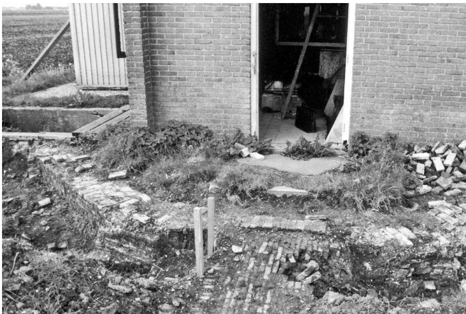
De molenfundering met het na de brand van 1959 gebouwde vijzelgemaal.
