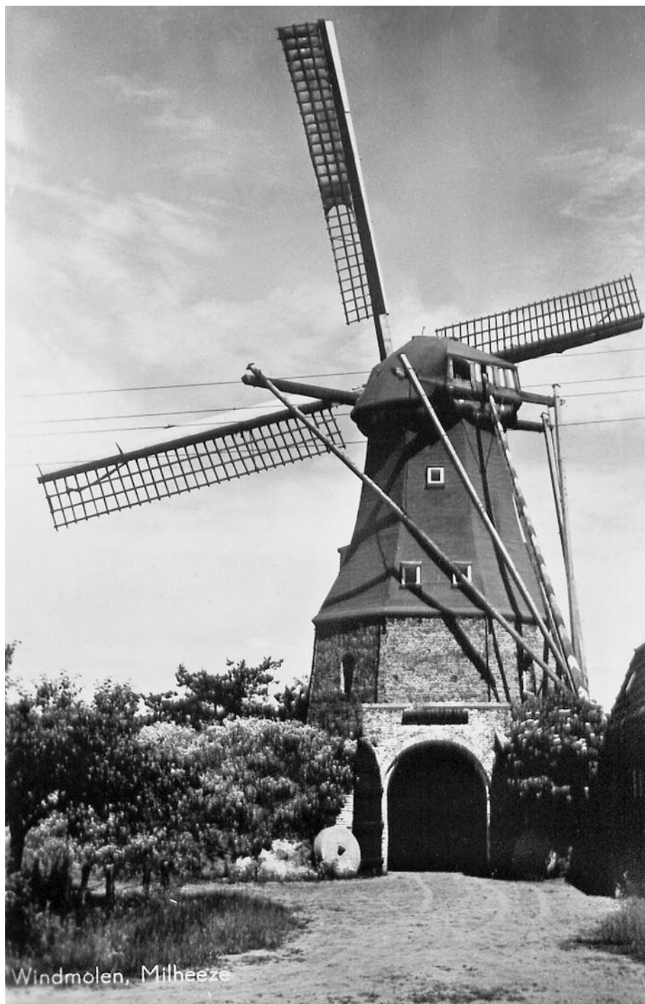
Molenaarszuinigheid uit de tijd dat dit moest: een molen 'trekt op de einden'; dan kun je dus best met halve zeilen toe, zeker als de molen, zoals deze in Milheeze, gestroomlijnd is.
