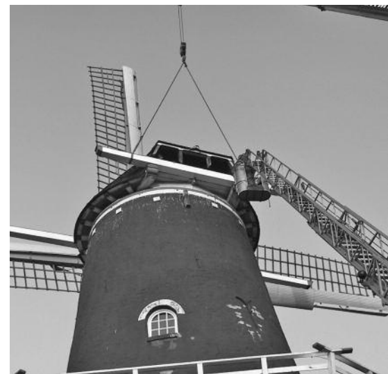
De korte spruit wordt op zijn plaats gebracht bij De Kroon in Arnhem (foto: A. Nibbelink).
