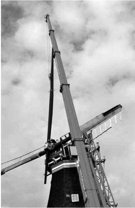
De nieuwe roede wordt gestoken in de molen van Den Andel (foto Martin E. van Doornik).
