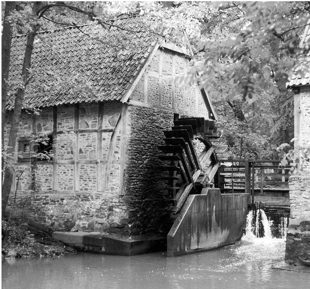
De dubbele molen Overmeyer in Hopsten-Halverde ligt schitterend in het landschap. De korenmolen wordt op dit moment maalvaardig gerestaureerd. Tevens komt er een turbine voor stroomopwekking. Aangezien waterkracht hier dus nuttig wordt gebruikt is voortbestaan verzekerd. Er zijn heel wat doemscenario's denkbaar als de stuwrechten bij een dergelijk stilliggende watermolen wegvallen.
