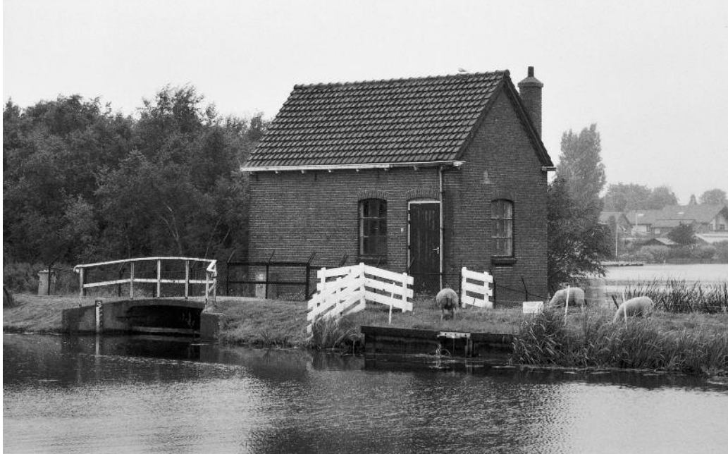
Het in 1929 gebouwde gemaal van de Noordeind- en Geerpolder.
