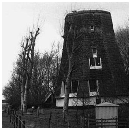
De scheefgezakte molen 6 van De Honderd Morgen bij Moerkapelle; historisch bijzonder waardevol als de oudste gebouwde, nog bestaande vijzelmolens in Nederland (foto jsb).
