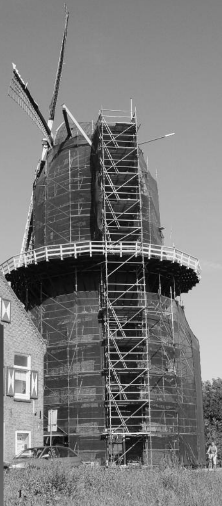
5. Het leggen van de as in de kap van de Murphy Mill (foto Verbij Hoogmade BV).
