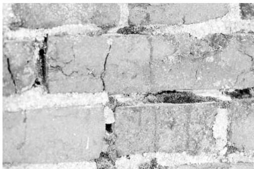
Het voegwerk van 1982 laat op plaatsen los.
