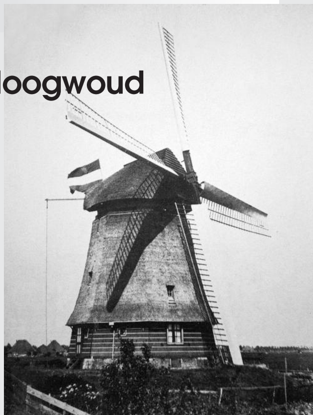
De molen De Vier Winden van de polder de Lagehoek onder Hoogwoud en Opmeer werd in 1934 verdekkerd. In 1961 werd deze modernisering weer ongedaan gemaakt.
