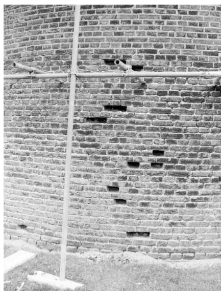
Plaatselijk breken zachte stenen en deze worden vervangen.
