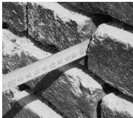
Het voegwerk van 1982 laat op plaatsen los.
