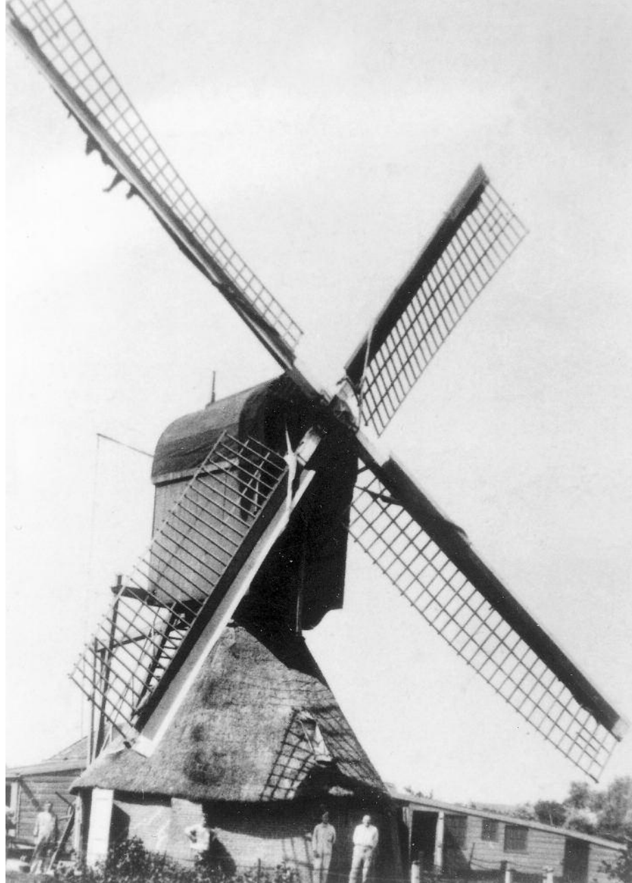
De schaduw van het overhangend riet is rechts van de steunbeer veel breder dan links. Uitgezakt riet of een hoek in de muur.
