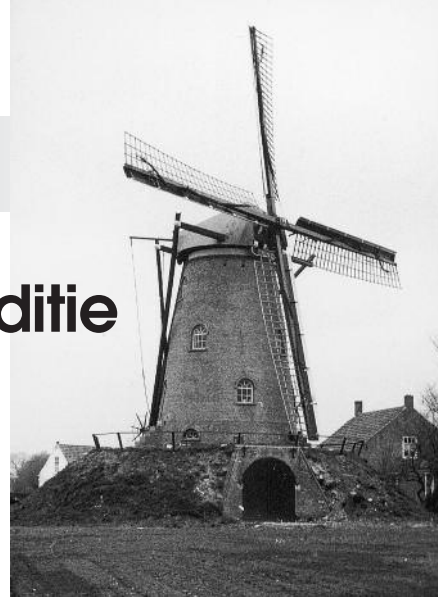
De molen van Cadzand hield de eerste decennia na de bouw in 1898 schoon metselwerk. In 1947 (?) werd de romp gewit. In 1974 brandde de molen uit. Na herstel weer schoon metselwerk.
