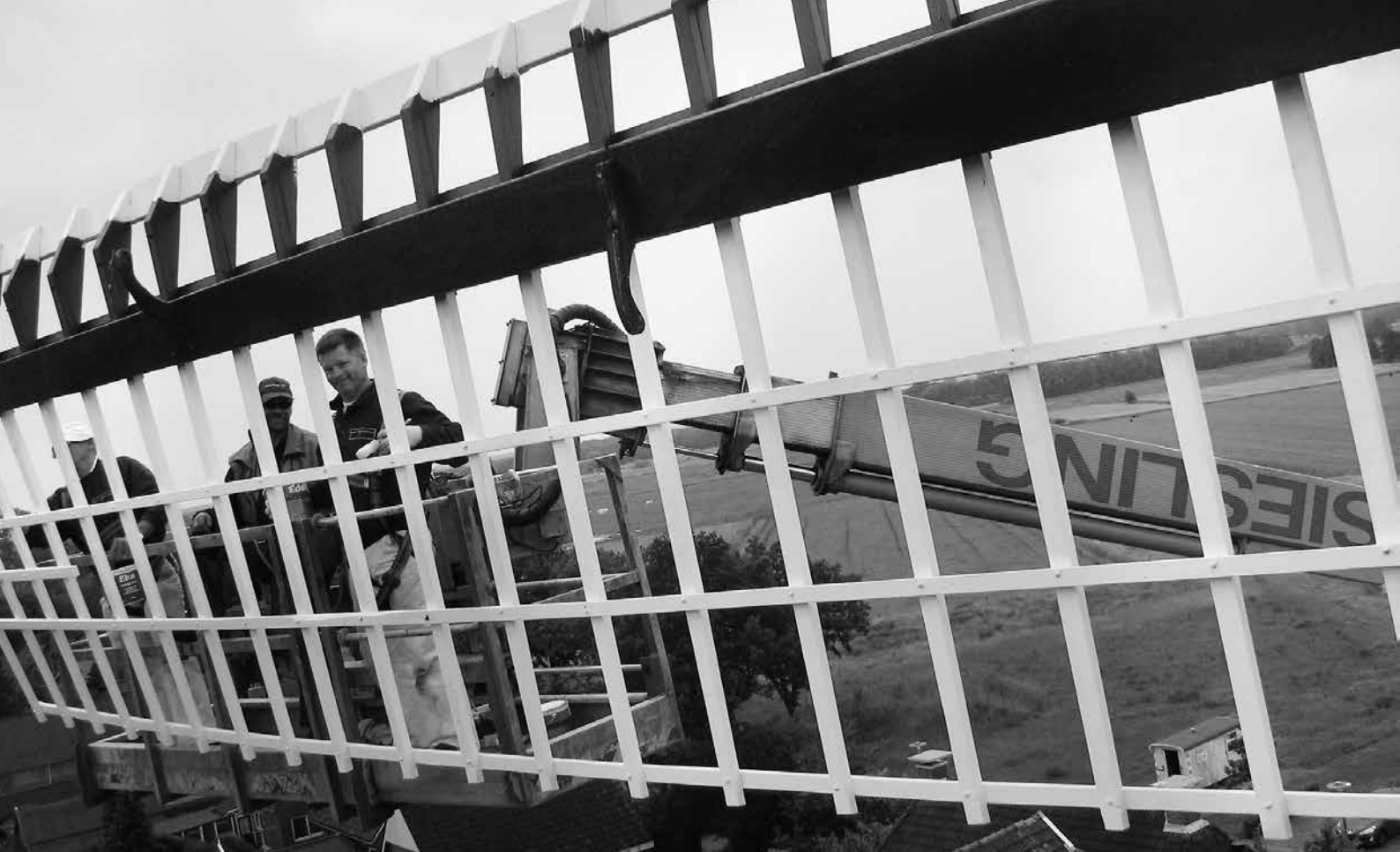
▲ Schilderen aan de Woldzigt op grote hoogte vanuit de hoogwerker (foto: M. Versteeg, 26 juni 2009).
