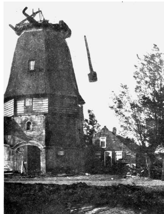
▲ De ontakeling van de molen in oktober 1931: de as wordt uit de molen gegooid.
