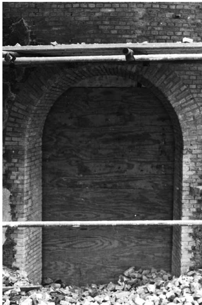
Bij de restauratie werd op gezag van Monumentenzorg de deuropening van De Haas in Benthuizen taps toelopend gemaakt. Waarschijnlijk kan een ouderwetse molenwagen nu alleen maar op zijn kant naar binnen. Het is een voorbered van het creëren van een 'onmogelijke' bedrijfssituatie door restauratie (foto jsb, 27 juni 1984).
