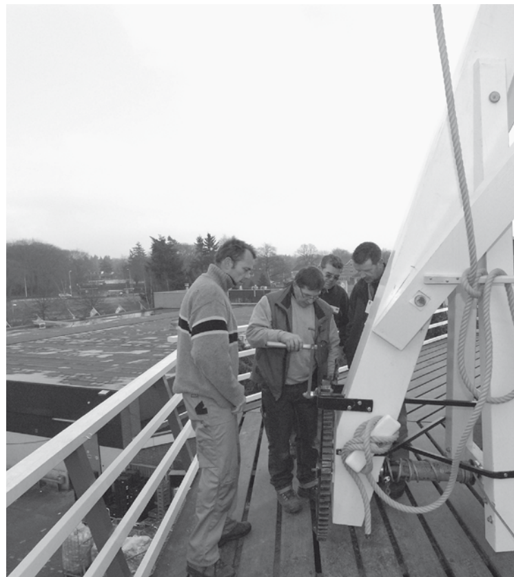
De kruilier is van afwijkend model, maar kwam in deze streek meer voor; bij de molen van Bunschoten bijvoorbeeld ook.
