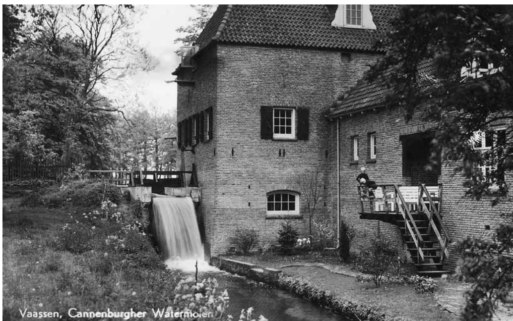
De Cannenburgher Molen niet lang na de nieuwbouw van 1943. De molen is toen als turbinemolen gebouwd en heeft nooit een waterrad gehad; geschiedvervalsing?
