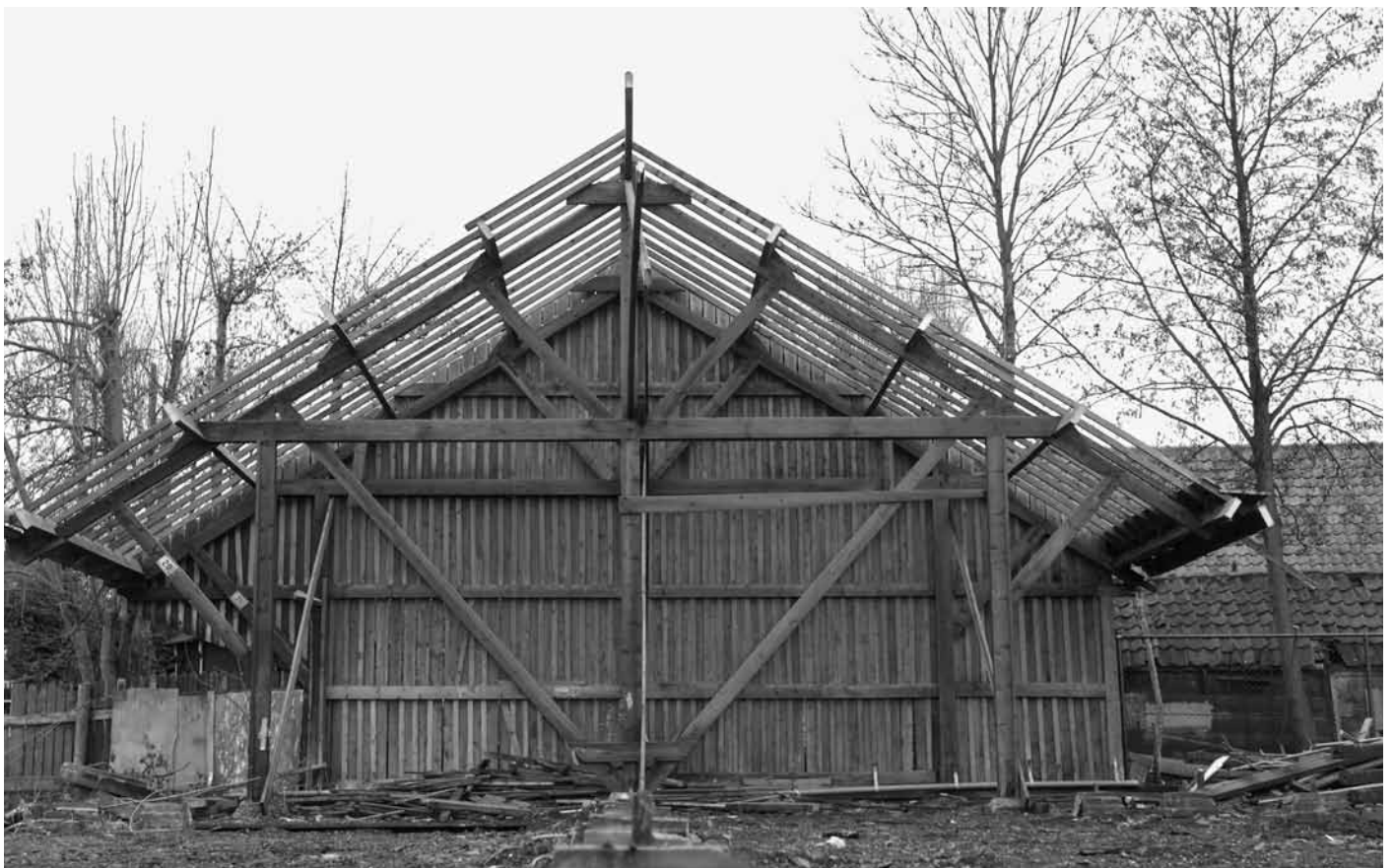
De houtloods in Westzaan tijdens de demontage (foto Parteon, 21 december 2008).
