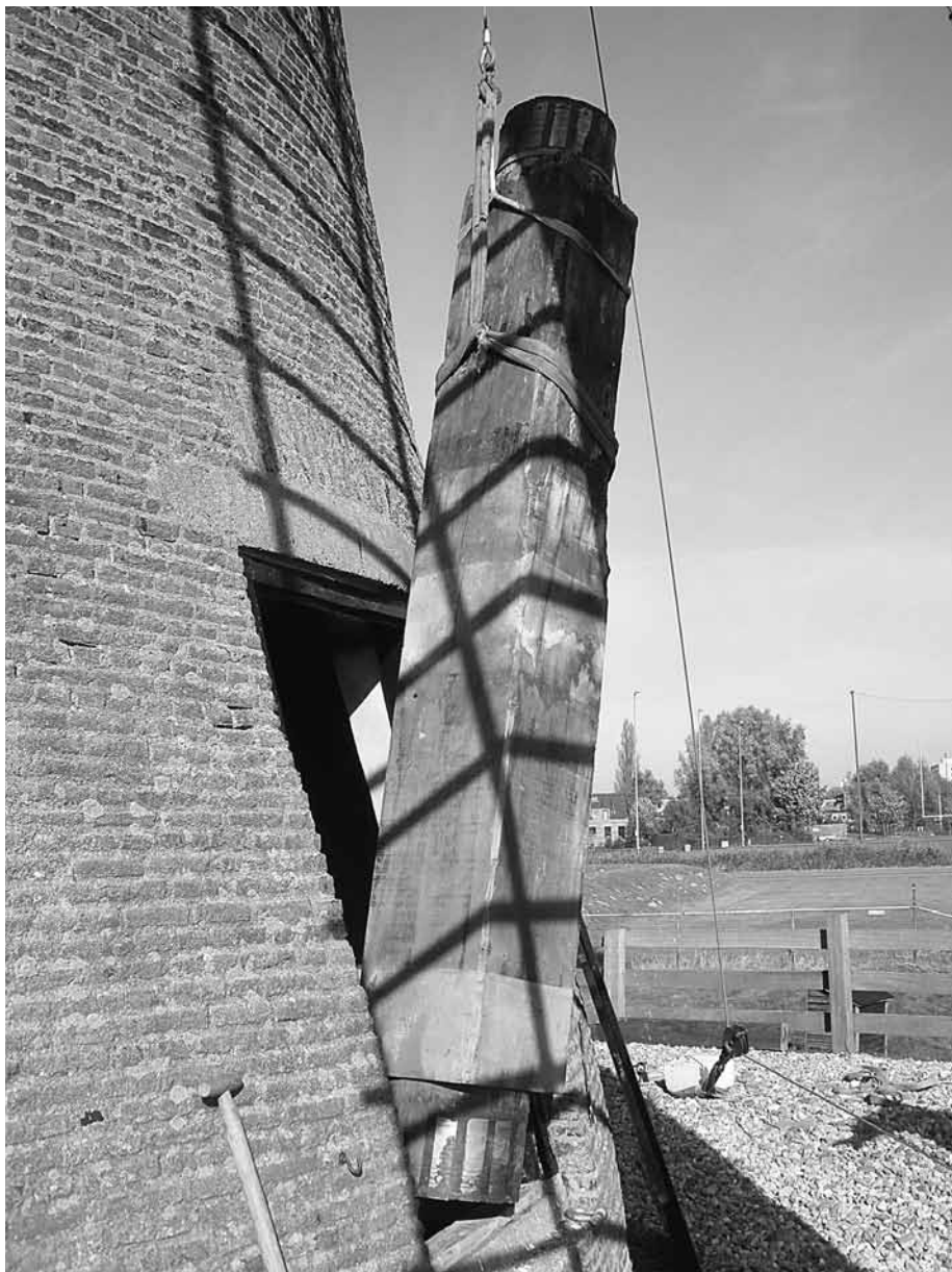
Vervanging van de wateras aan de Pendrechtse molen (foto J. Althof, 20 oktober 2008).
