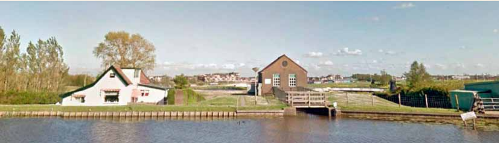
▲ Het bestaande Middengemaal aan de Polderweg in Berkel op de plaats van de vijzelmolen van de Westpolder. Het huis links is mogelijk het zomerhuis van de molen (foto Google Streetview).
