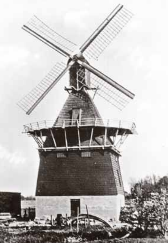
▲ De opgevijselde molen op de gemetselde voet die vorig jaar weer aan het licht gekomen is. Op de voorgrond twee velgstukken van een wiel met grote diameter, waarschijnlijk van het wiel dat de kollergang in de molen aandreef. Bas Koster rekende voor de diameter van dit wiel 3,18 m en dat komt op hetoog goed overeen met de diameter van de velg.
