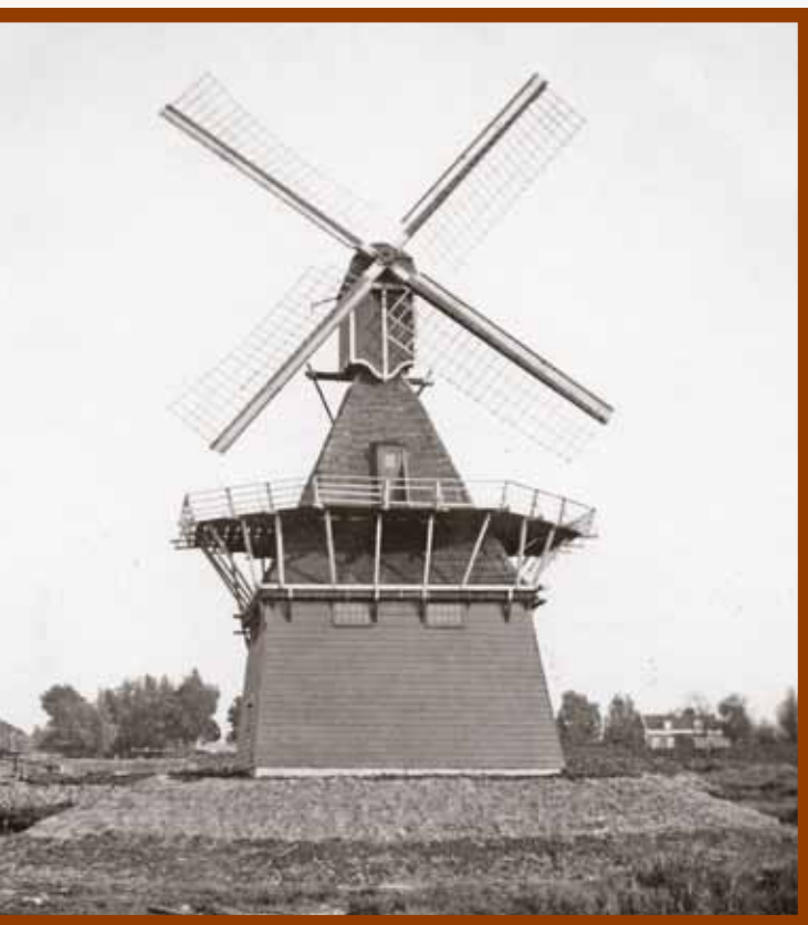
▲ De opgevijselde Meerkoet omgeven door een aarden wal voor het begin van het opspuiten. Links is te zien dat de molen al flink verzakt is. Men mag tenminste aannemen dat de molen waterpas is neergezet.
