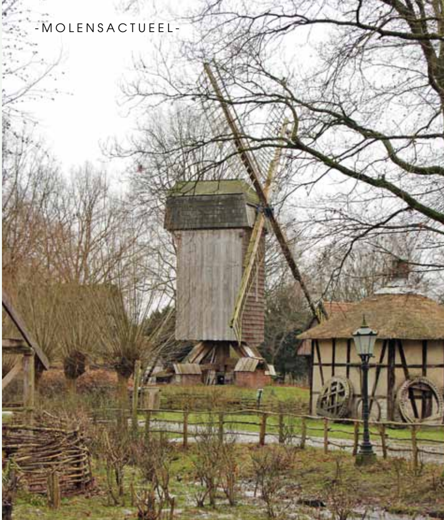
▲ De standerdmolen in het openluchtmuseum Mühlenhof, bekend als een linksom draaiende molen (foto Bernhard Fritsche, 30 december 2014).
