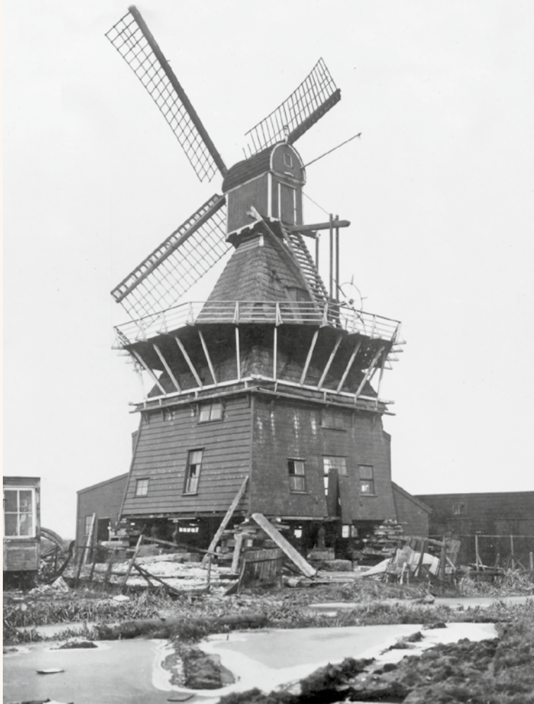
▲ Het opvijzelen van De Meerkoet (foto Gemeentewerken Rotterdam).
