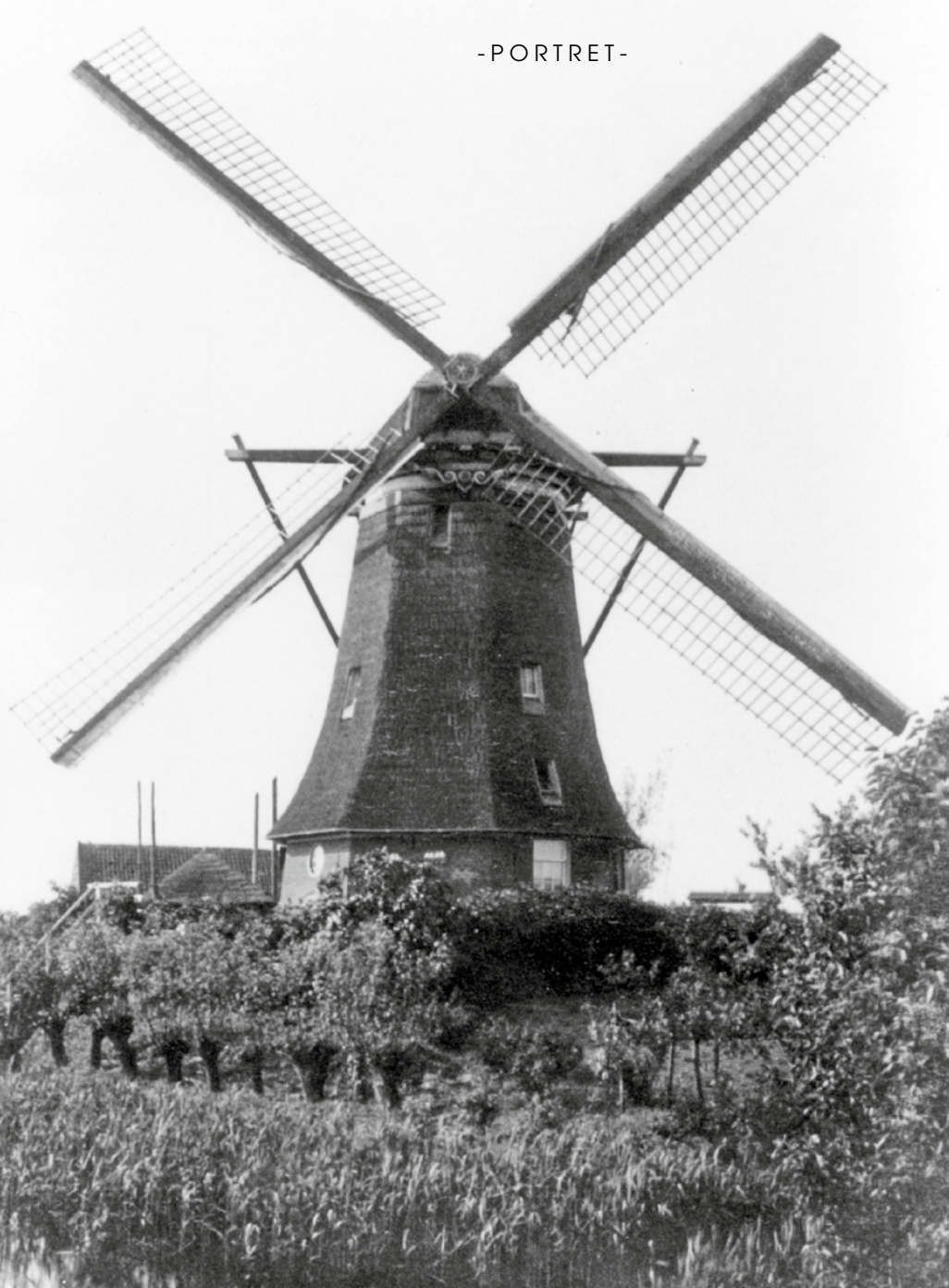
▲ De molen van de Droogmaking in de Oude Polder van Pijnacker, ook ontworpen door J.P. van den Berg Jz. Het was een klossale molen met maar liefst 30 m vlucht. De stomp van de molen doet nog steeds dienst als gemaal en is inmiddels rijksmonument.
