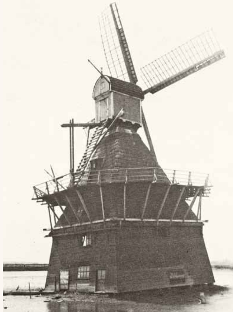
▲ De Meerkoet na het opspuiten. De bagger staat aan de vensters en de scheefstand is aanmerkelijk toegenomen (vergelijk de horizon).
