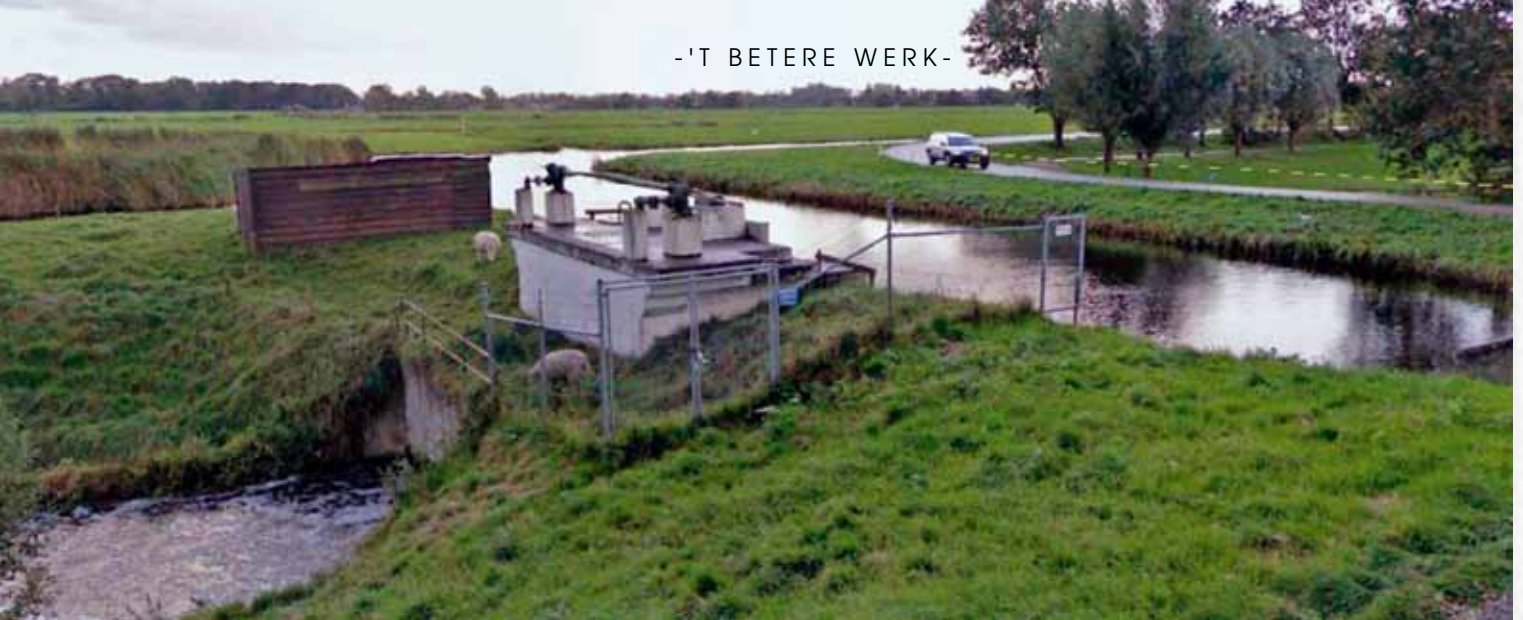
▲ Een duiker onder ringsloot en de Bankrasweg (ringdijk van de polder) voert het water uit de droogmakerij via een tocht door de bovenpolder naar het gemaal aan de Amsteldijk. Een dergelijke oplossing zal het polderbestuur ook voor ogen hebben gestaan bij de vernieuwing van de Bankrasmolen in 1857 (foto Google Streetview).
