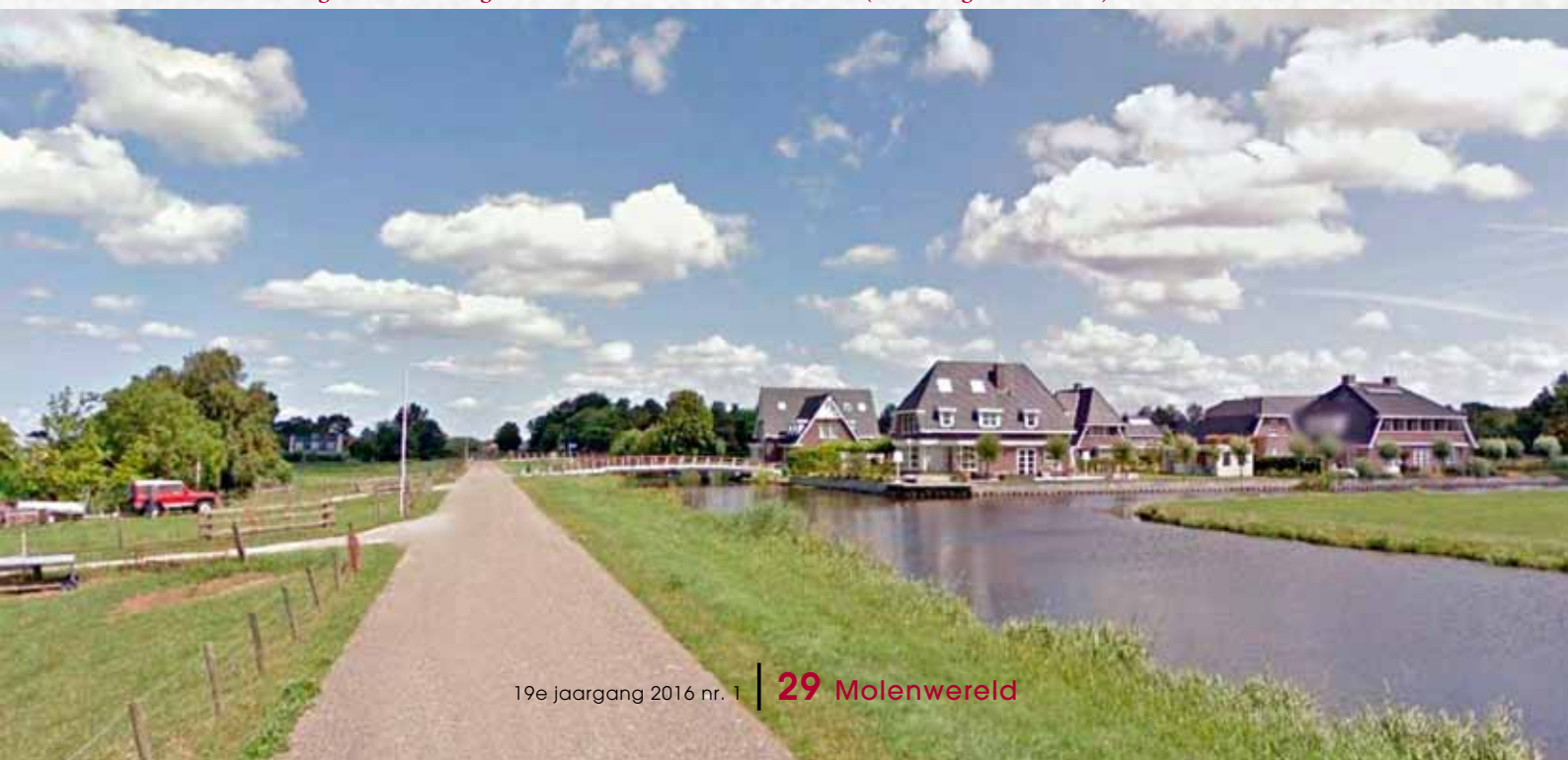
De Bankrasweg noordwaarts gezien. Het bruggetje illustreert het nagenoeg gelijke niveau van de ringdijk en de bovenpolder. De zijvaart naar rechts vanuit de ringsloot is de vroeger molensloot voor de Bankrasmolen (foto Google Streetview).
