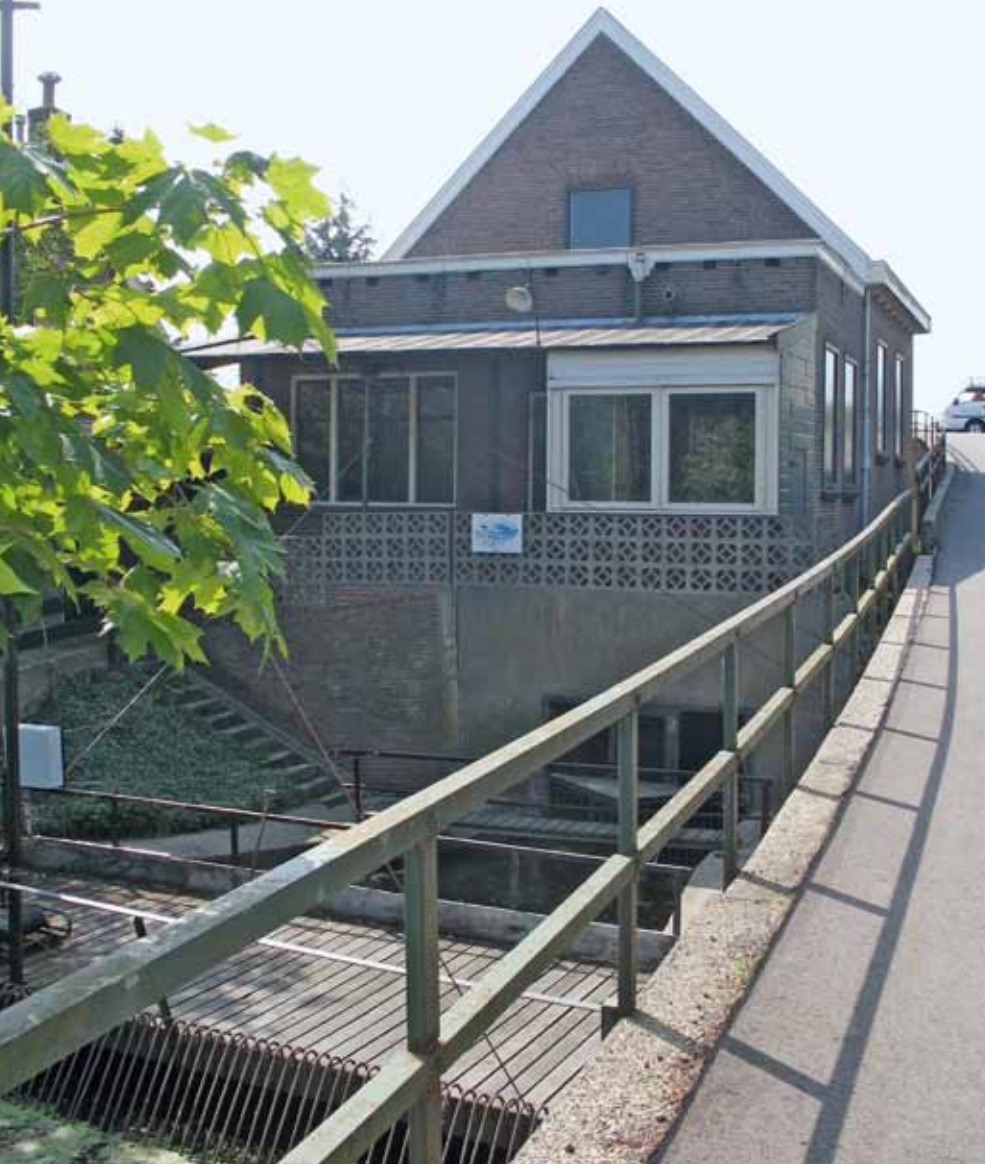
▲Achterzijde van het gemaal (foto: 5 juni 2010).
