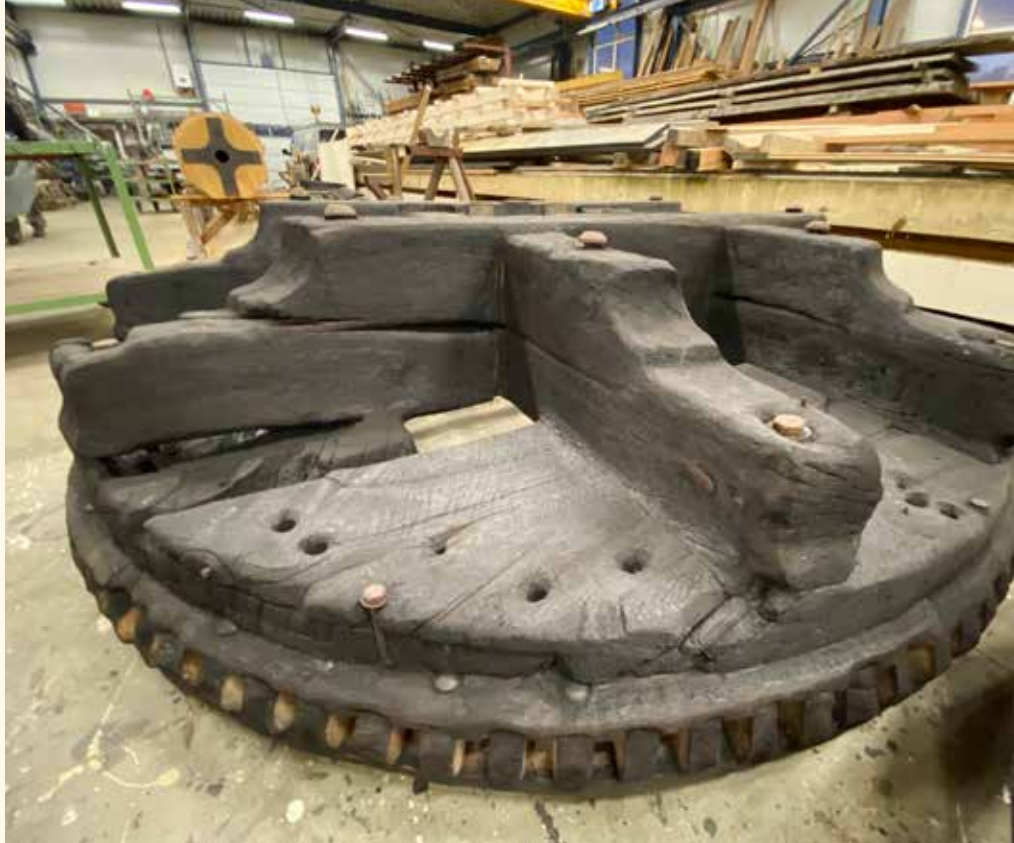
Het schoongeschrapte spoorwiel van de Ceres in de werkplaats van de molenmaker (foto Jan Poland).
