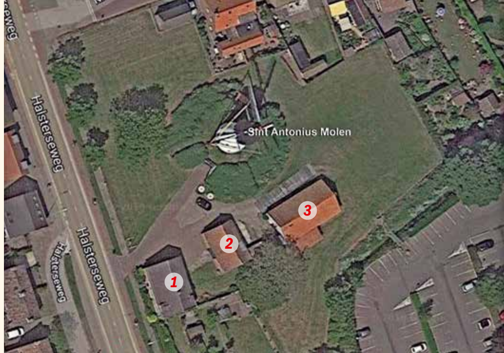
Een recente luchtfoto van de Sint Antoniusmolen, het molenerf en de bijgebouwen. 1 = molaarswoning annex pakhuis, 2 = schuur, 3 = loods (bron Google Maps).
