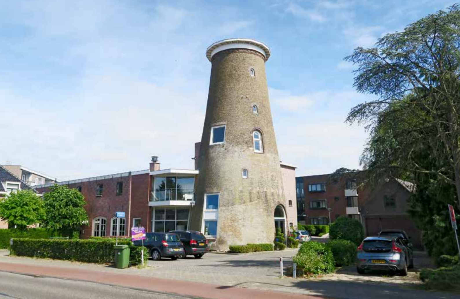
De situatie rond korenmolen De Nachtegaal in Heemstede was goed vergelijkbaar met die in Bunnik. Hier bleven molenromp en meelfabriek behouden, zij het als kantoor, resp. appartementencomplex (Foto Erwin Esselink, 31 mei 2019).
