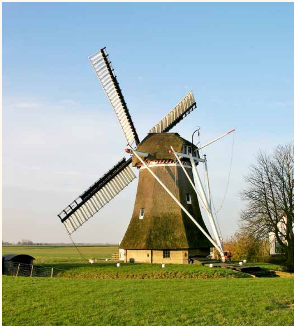
30. De Marssummolen met uiterst links de afdekking van de inhaalvijsel. Bij het zwarte luikje gaat de aandrijfjas naar buiten (foto Jan Hofstra, 9 januari 2018).
