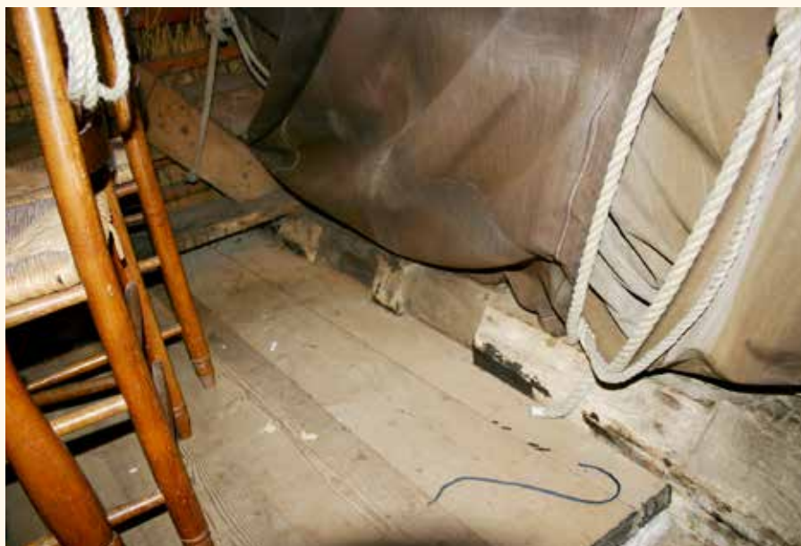
25. Dwars over de schepradzolder lopen in de Meermolen in Muiderberg nog twee balken met uitkepingen voor wielen. Voor de oriëntatie: de stoelen staan op de schepradzolder, waarvan de planken evenwijdig met de wateras lopen. Rechtsonder is nog een stukje schermmuur te zien en links een veldkruis (foto Jan Hofstra, 25 maart 2009).
