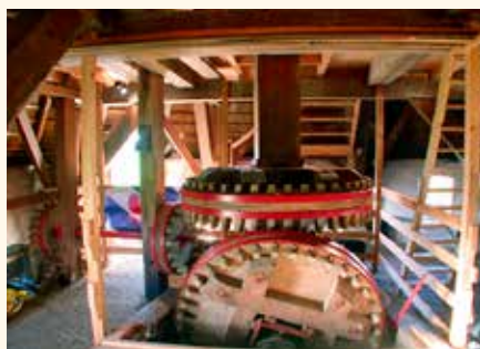
29. Bij de Marssummolen bevindt de inhaalvijsel zich buiten de draaicirkel van de roeden en de staart en loopt de aandrijfjas door een goot onder het maaiveld tot in de molen. Op de voorgrond de aandrijving van de gewone vijsel en links die van de aandrijfjas, waarvan het rad half in de grond zit (foto Rijksdienst voor het Cultureel Erfgoed, 2002).
