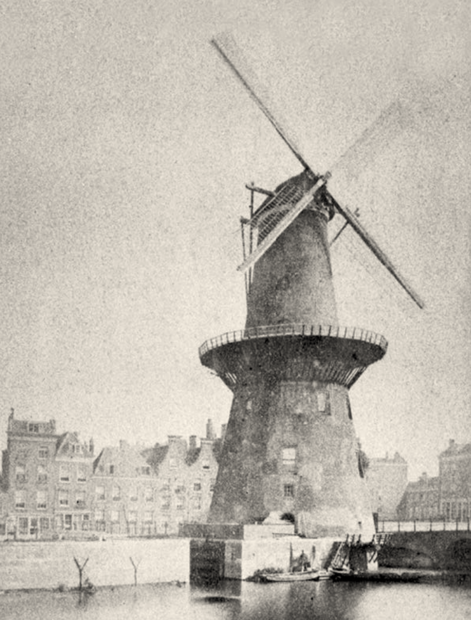
9. De Kostverlorenmolen bij het Oostplein voor het bemalen van de Rotte, gebouwd in 1742 en afgebroken in 1870 (foto collectie Rijksdienst voor het Cultureel Erfgoed).
