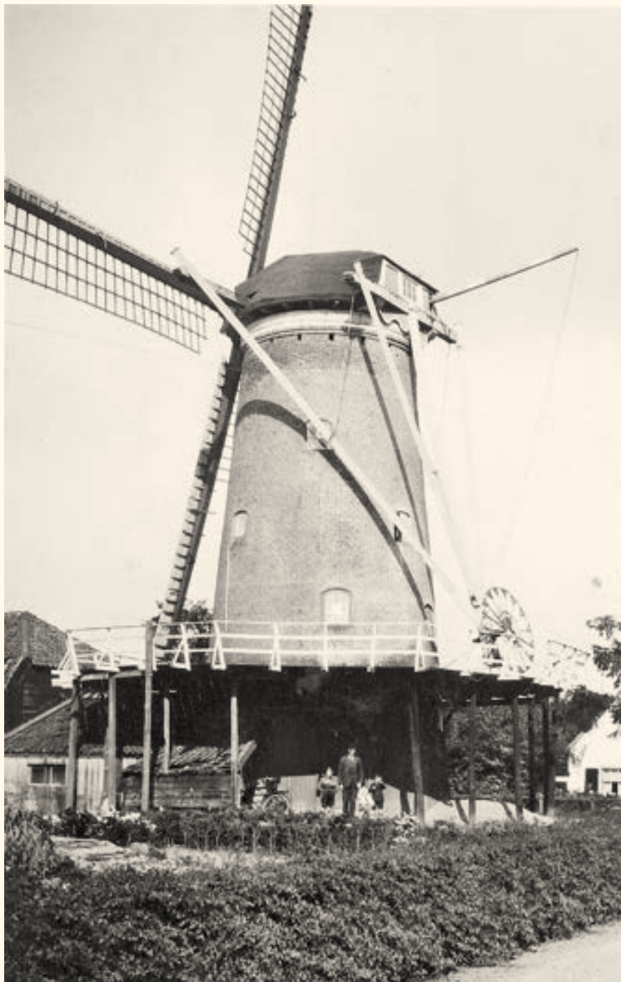
De molen in zijn nadagen: de zeilen zijn afgenomen en het hekwerk van het onderste eind ontbreekt grotendeels. Bemerkt het opvallend grote kruirad met loopklossen, dat ook al op de oudste foto's te zien is. Deze foto is waarschijnlijk gemaakt in september 1930 en door Piet van Zijl geschonken aan de Hollandsche Molen (foto collectie Vereniging De Hollandsche Molen).
