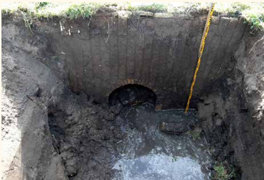
17. De halfronde opening in een van de twee dwarsmuren van de waterkelder op de vorige foto (Hollandia, Zaandijk, 2009).
