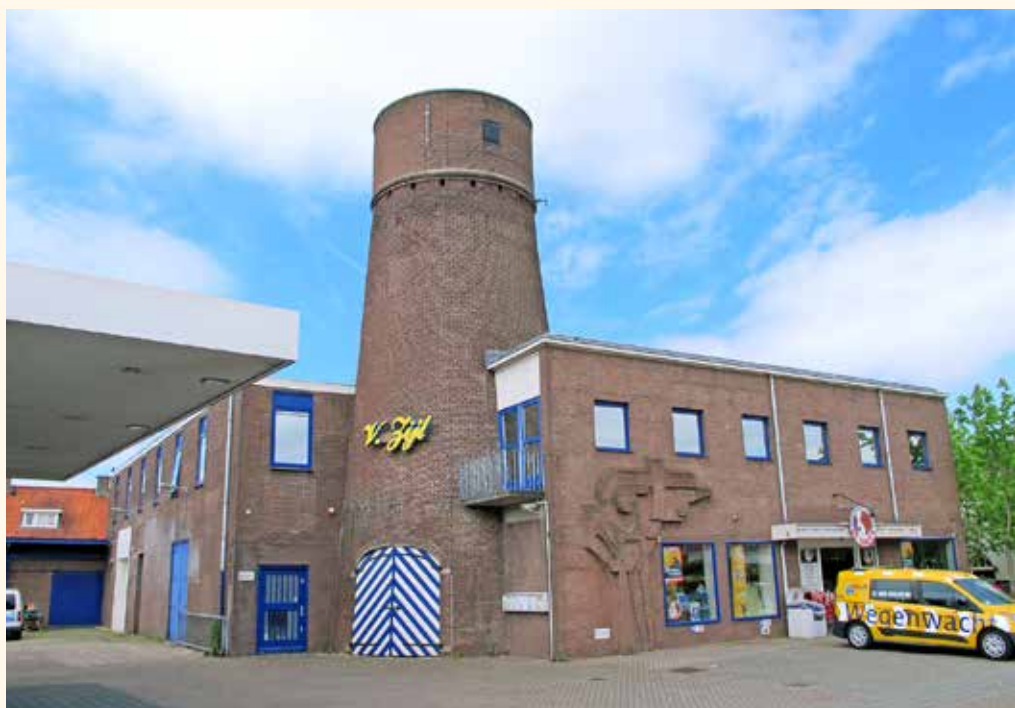
De bedrijfsgebouwen van Van Zijl voor de afbraak. Bemerkt het kunstige reliëf in het metselwerk van de aanbouw, waar tot eind 2018 de dierenspecialzaak gevestigd was (foto Erwin Esselink, 24 mei 2017).
