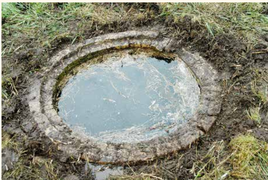
6. De onderzijde van de van gele steentjes gemetselde put op het land van de Vergulde Bijenkorf. De doorsnede bedraagt ongeveer anderhalve meter (foto Hollandia, Zaanwijk, 2009).
