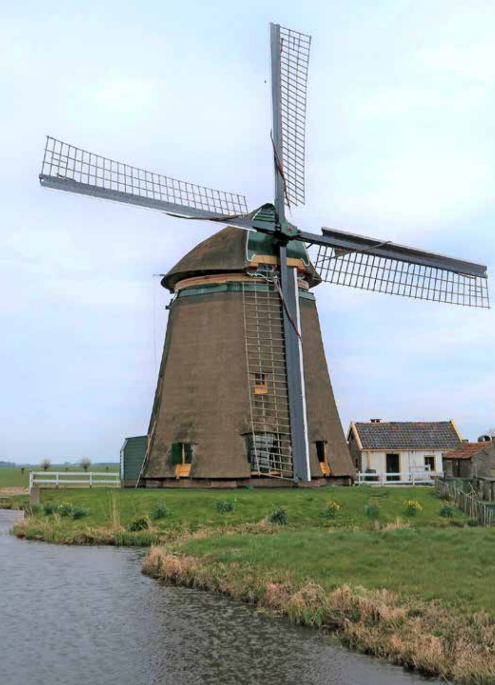
De Hondsdijkse molen in Koudekerk aan den Rijn is de enige binnenkruier in Zuid-Holland. In 1644 werd hij in Leiden als stadswaterverversingsmolen gebouwd, in navolging van het bestek zoals door de twee Leidenaars uit de Beemster meegenomen. In 1693 werd hij verplaatst naar Koudekerk en werd een buitenkruier. De molen is in 1981 teruggerestaureerd tot binnenkruier (foto auteur, 2020).
