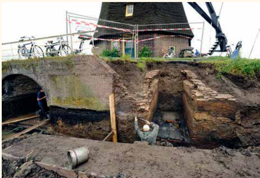
6. Overwaardmolen nummer 4 tijdens de restauratie van 2009. Links de gewone achterwaterloop en rechts de ontgraven voorwaterloop van het vervallen scheprad (foto stichting Werelderfgoed Kinderdijk).
