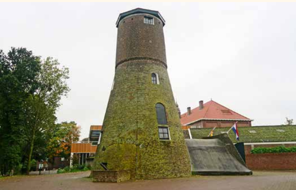
De molen terugbrengen naar de toestand waarin deze voor het laatst in bedrijf was, is in Roermond letterlijk genomen. Alle ontwikkelingsfasen van de Kepelse Meule zijn nog af te lezen: de bouw als grondzeiler, de latere verhoging tot bergmolen en uiteindelijk de onttakeling en inrichting tot elektrische maalderij. Dit resulteerde in een voor Nederland uniek complex (foto Erwin Esselink, 6 oktober 2019).
