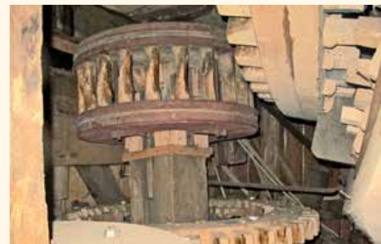
Een dubbele achtermolen, uitgevoerd met koning en spoorwiel, zoals aanwezig in standerdmolen Tot Voordeel en Genoegen te Alphen aan de Maas. De Akkermolen moet ook een dergelijke inrichting hebben gehad (foto Erwin Esselink, 10 mei 2014).
