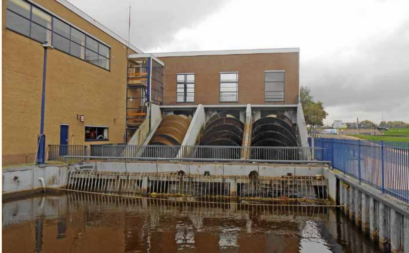
In 1972 werd het J.U. Smitgemaal in gebruik genomen. Het met drie vijzels uitgeruste dieselgemaal brengt het water naar een maalkom, waarna het op de Lek wordt geloosd. De vijzels zijn in lengte verstelbaar, waardoor er met verschillende waterstanden gemalen kan worden (foto Peter van der Molen, oktober 2019).
