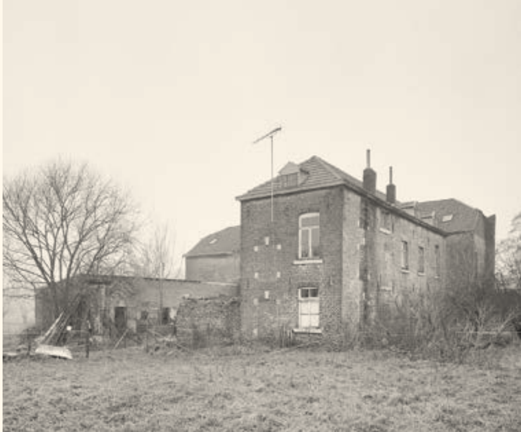
De Frankenhof in Holset in 1999. Het lage bouwdeel links is de voormalige westvleugel, die enkele decennia eerder geheel was afgebrand en daarna provisorisch en gedeeltelijk weer opgemetseld (foto A.J. van der Wal, collectie Rijksdienst voor het Cultureel Erfgoed, objectnr. 331.240).
