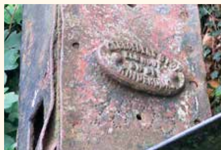
De binnenroede van de Akkermolen ligt tegenwoordig naast molen De Welvaart in Horn. Het Potplaatje en nummer 1803 zijn bij het inkorten van de roe tot een lengte van 22 meter net behouden gebleven (foto Erwin Esselink, 20 september 2017).
