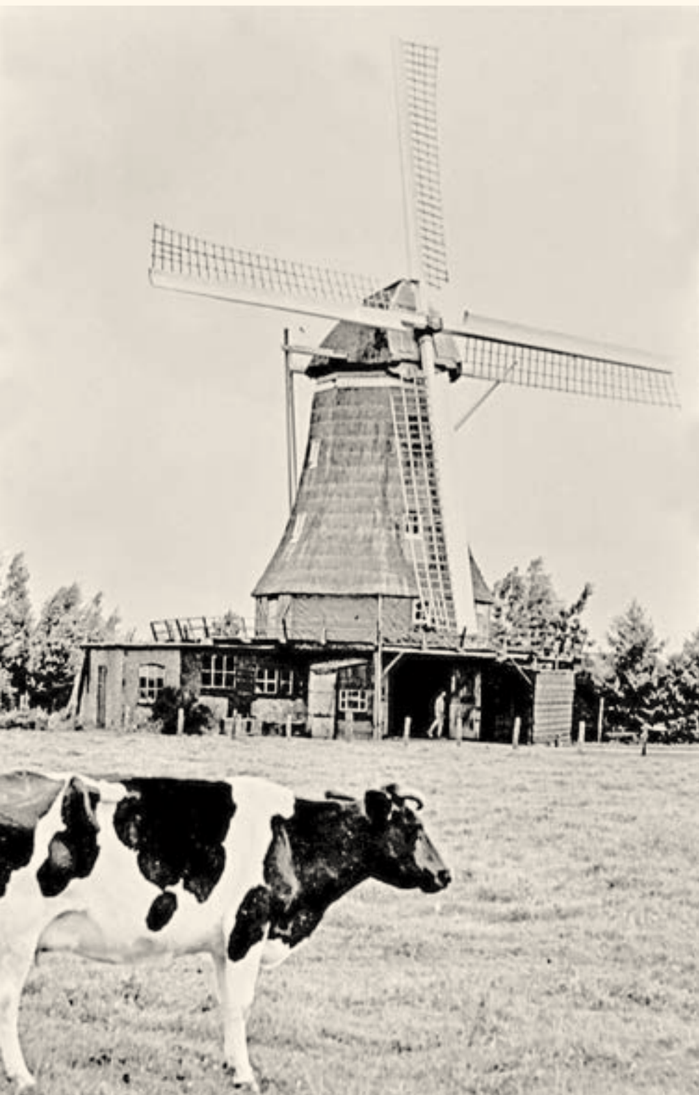
De molen na de restauratie van 1943, waarbij het gevlucht verbusseld werd. Naar verluidt liep de molen zeer licht. Helaas duurde de opleving van de windmolen nog geen twee jaar (foto collectie Vereniging De Hollandse Molen).
