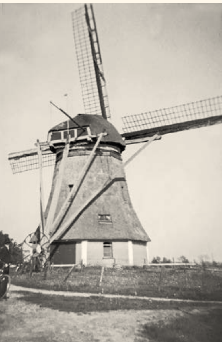
'Broertjes': links de molen van Wenum rond 1940 met Oud-Hollandse ophekkings en een groot kruirad met loopklossen (collectie Ton Meesters). Rechts de Oostzijdse molen in Abcoude in 2020 met zo'n zelfde kruirad. Verder komen romp- en kapvorm sterk overeen (foto Robert Jan Prins).
