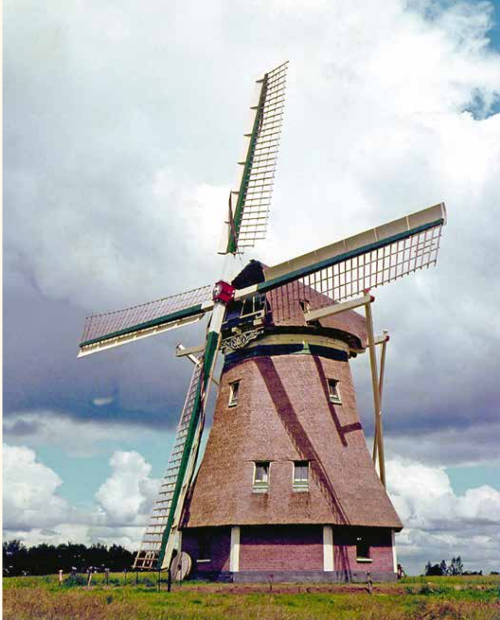
De molen vlak na de restauratie van 1965 met fokwieken en een nieuw rietdek (collectie vereniging De Hollandse Molen).
