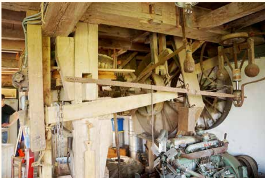
Motorische onderaandrijving van één van de koppels stenen (2019, foto Ton Meesters).
