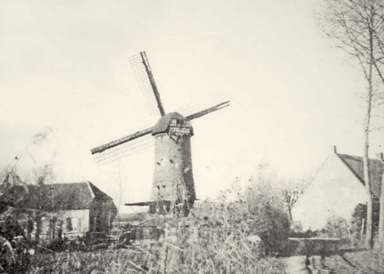
Van deze foto, die gedateerd is in november 1937, bevindt zich slechts een fotokopie in de verzameling van de familie Potters. Eerst nu is duidelijk geworden in wat voor bijzondere omstandigheden deze opname gemaakt moet zijn. De molen is in scheefstand geplaatst en staat kennelijk voor langere tijd stil; de stormplanken (eindborden) van de twee hoogst reikende enden van het wiekenkruis zijn uitgenomen. Het is onmiskenbaar: de molen staat in de rouwstand vanwege het dodelijke ongeval dat mulder Jan Potters enkele weken eerder is overkomen (reproductie Jan Klerks).
