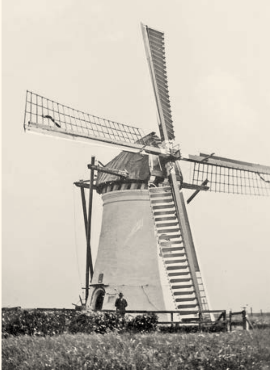
Op deze foto van voor 1944 uit het archief van De Hollandsche Molen is de zelfzwichting te zien. We zien goed de doorboorde bovenas. Voor de molen staat molenaar Coomans. De molen heeft op de kuip een diagonale beschildering. Volgens molenaar Willem Dijkman uit Haamstede was dit afgekeken van de vuurtoren van Haamstede. Ook andere molens van de familie Dijkman hadden deze uitvoering van de kuip. Van 1896 tot 1920 was de molen eigendom van deze familie.
