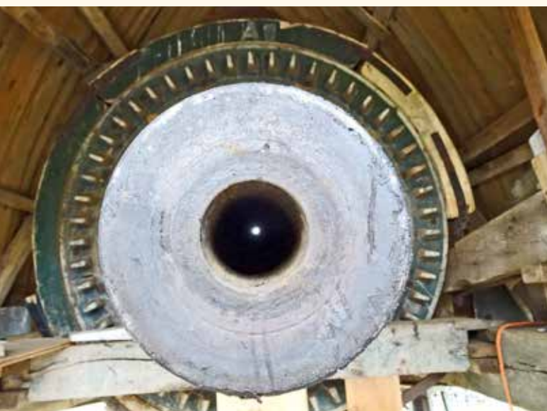
Een kijkje door de as. Door dit gat liep de zwichtstang om de zelfzwichting te bedienen (foto J. de Witte, voorjaar 2019).
