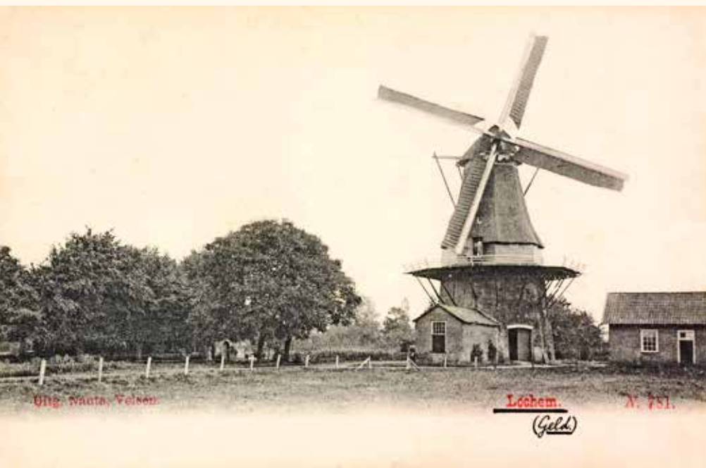
De Hoop malend op het westen omstreeks 1900 en gezien vanaf de Stationsweg, later omgedoopt tot Graaf Ottoweg. De stelling lag ongeveer een meter lager dan de stellingzolder en was via een trapje bereikbaar (prentbriefkaart collectie Vereniging De Hollandsche Molen).
