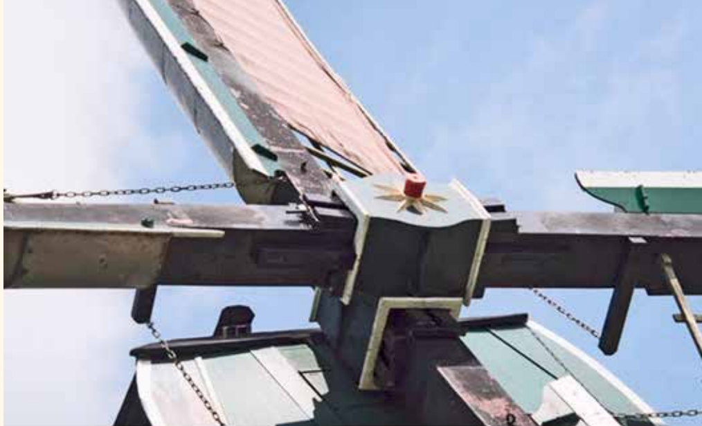
Groenendijksemolen te Hazerswoude-Rijndijk met nog het oorspronkelijk door A.J. Dekker toegepaste stroomlijnsysteem, waarbij alleen de achterzijde van de windborden met metalen platen werd bekleed (foto Pieter Sleeboom, mei 2019).
