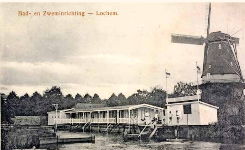
In of kort voor 1905 kreeg De Hoop een nieuw gevluht met zelfzwiching. De houten as werd hiervoor doorboord. Achter de molen bevond zich zwem- en badinrichting De Berkel. In de crisistijd werd het nieuwe natuurbad Stijgoord aangelegd aan de overzijde van de Berkel, dat bestaan heeft van 1935 tot 1993 (prentbriefkaart collectie Vereniging De Hollandsche Molen).
