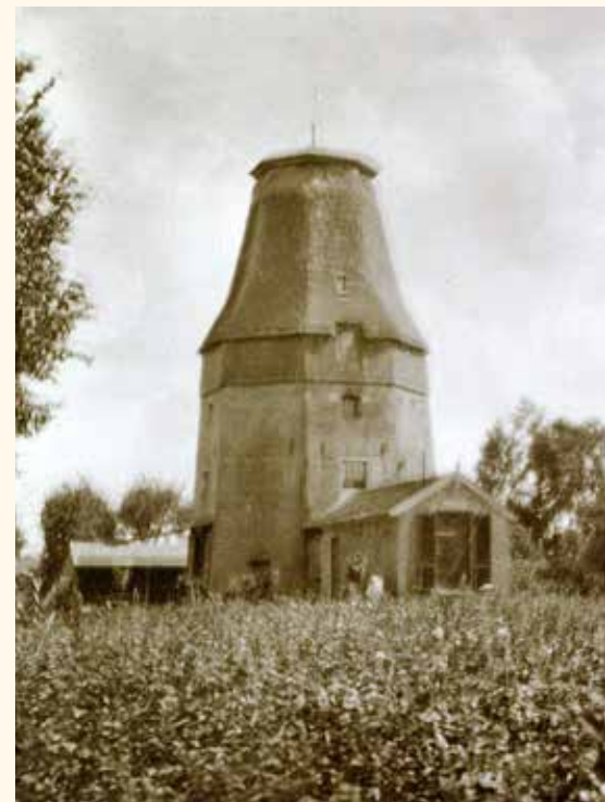
Vanaf 1916 stond de molen als romp zonder kap en werd er dus alleen nog motorisch gemalen. In 1938 werd er een groot pakhuis tegen de molen gebouwd en het houten achtkant vervangen door een opbouw van steen, waarin silo's waren ondergebracht (foto collectie Vereniging De Hollandsche Molen).
