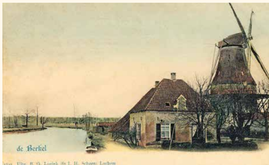
De Hoop met molenaarshuis omstreeks 1900, gezien vanaf de Hoevenbrug. De molen heeft nog een geheel houten gevucht, uitgevoerd met borstroeden (prentbriefkaart collectie Erwin Esselink).
