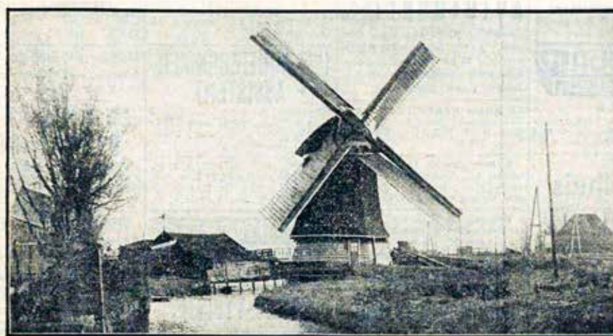
De mooie molen van den Sluispolder te Bergen is de eerste waar het systeem-Eriksson als hulpbemaling is toegepast. Zoals men weet is dit systeem bekroond bij de door „De Hollandsche Molen” uitgeschreven prijsvraag. Een dezer dagen gehouden proefbemaling gaf uitmuntende resultaten. Het staat vast dat deze mooie molen behouden blijft. Welke volgen?
