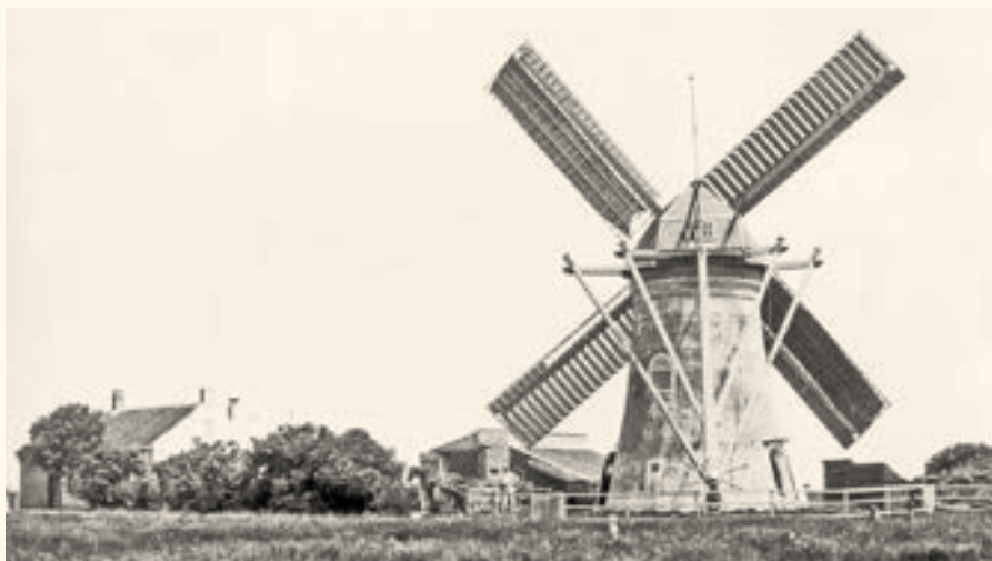
Op deze 'statiefoto' zien we de molen rond 1925. Eén roede is voorzien van zelfzwichting. De as is hiertoe doorboord en voorzien van een zwichtstang (collectie Vereniging De Hollandsche Molen).
