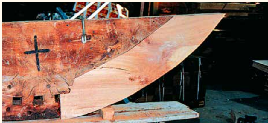
Vooruitstrevendheid in conserverend restaureren. Molenmaker Beijck vernieuwde in 2003 van het oude bovenwiel van de standermolen in Urmond slechts die onderdelen die echt aan vervanging toe waren.
