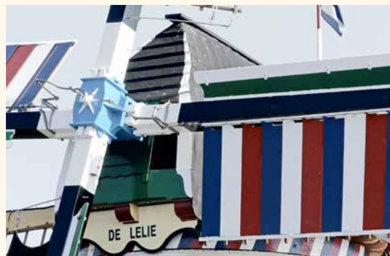
Een detailopname van de nieuwe kleppen en zwichstang (foto F. van Reeve, 2019).
