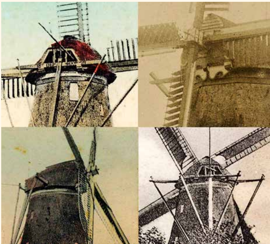
Collage van Zaanse kenmerken: achterkeuvelens en teerdeur, vorm van de baard, middelbalk en stand van de vangstok: deze wijst naar links onder, wat betekent dat de vangbalk naar rechtsboven bewogen is om met een kram opgehangen te worden aan een ijzeren klamp of duim (foto's uit de collecties van Vereniging De Hollandsche Molen en Erwin Esselink).
