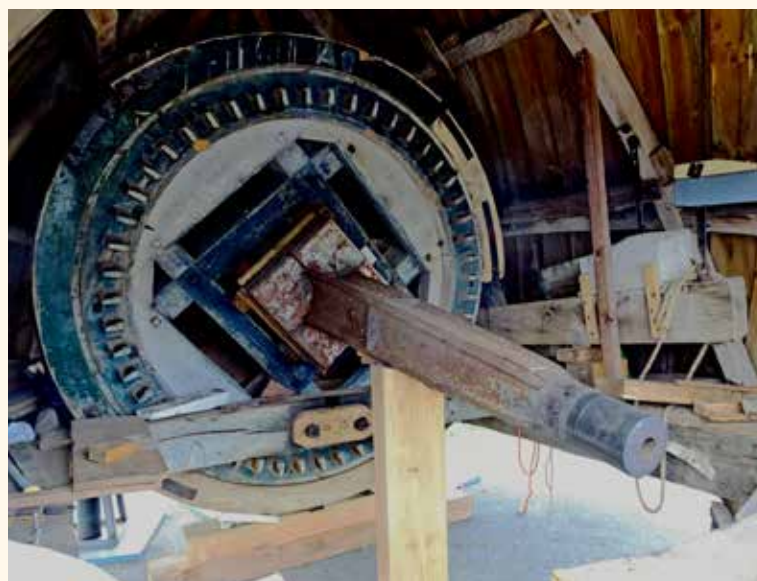
Bovenas met rechts de vangbalk die boven het voeghout ligt. Opvallend is dat het bovenwiel evenals het andere gangwerk beschilderd is (foto J. de Witte, voorjaar 2019).
