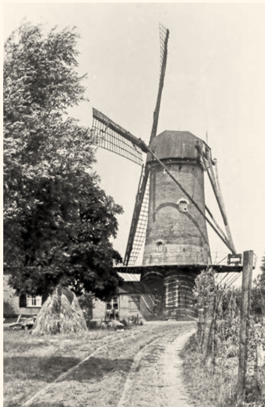
De Kilsdonkse molen op een ansichtkaart van omstreeks 1950. De molen is dan nog compleet (bezit zelfs nog zijn zeilen), maar de foto laat wel zien dat onderhoud lange tijd is uitgebleven. Het gezin Potters woonde toen nog in het voormalige watermolengebouw links. Het gebouwtje midden op de foto, tegen de molenromp aan, herbergde de Dieselmotor (foto collectie Vereniging De Hollandsche Molen).
