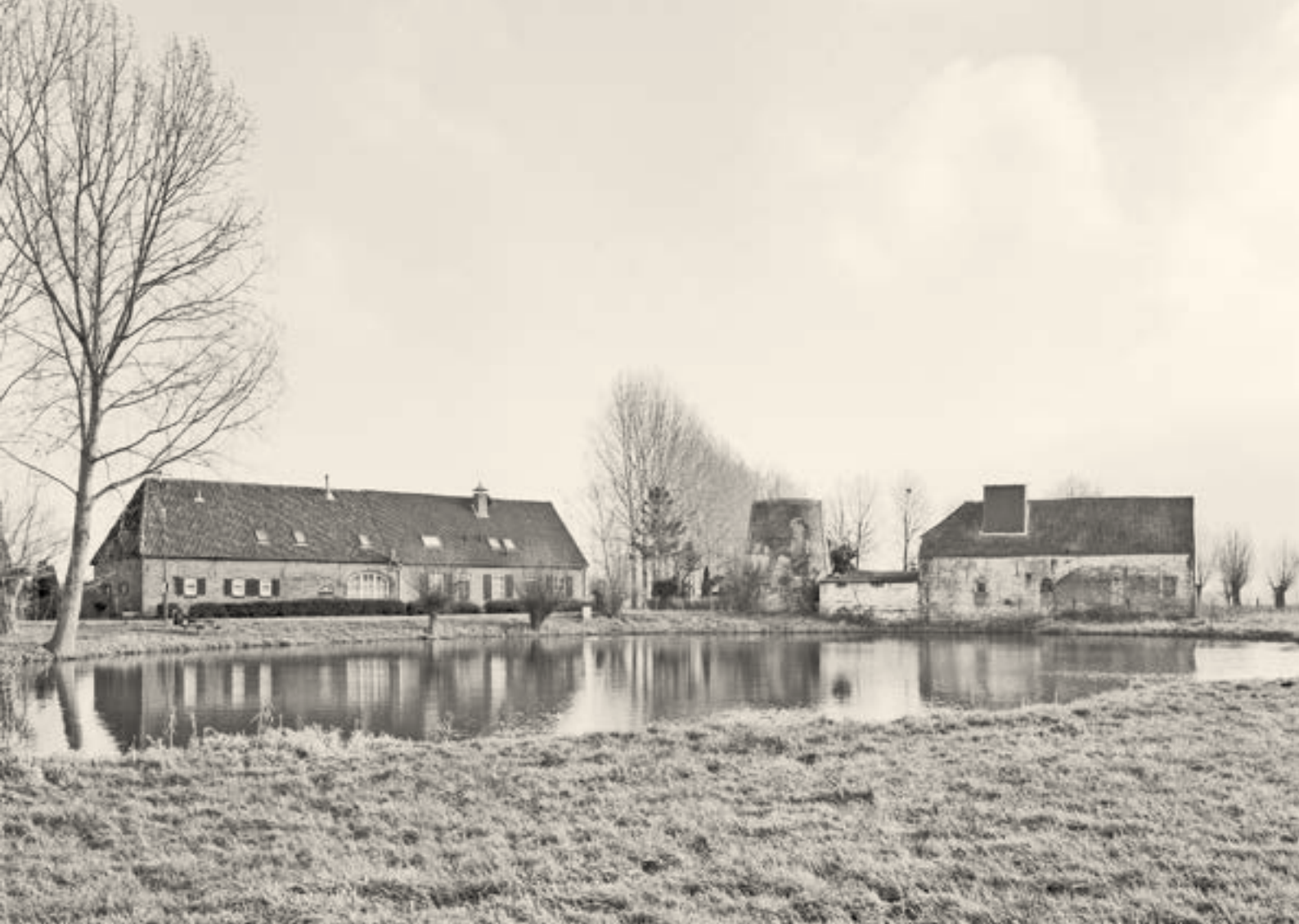
Tot het molencomplex behoorden voorafgaand aan het herstel niet alleen de romp van de windmolen en het watermolengebouw, maar ook het (helaas gewijzigde) oude molenhuis links en de restanten van de molenwiel (foto G. Barbiers, collectie Rijksdienst voor het Cultureel Erfgoed, objectnummer 336.359, januari 2001).
