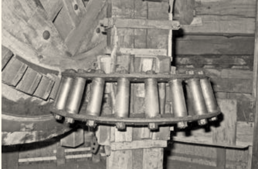
Stalen schijfloop met daarin draaibare staven, in de molen van de polder Waardenburg (foto I.J. de Kramer, 20 oktober 1971, collectie Vereniging De Hollandsche Molen).
