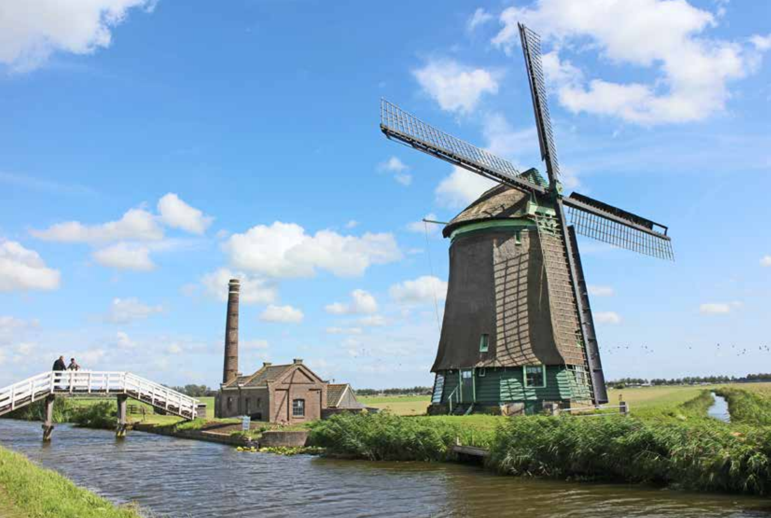
De Wijzend met aan de overkant de Kaagmolen met het hulpstoomgemaal. Rechts van het gemaal de kolenloods. Het nieuwe elektrische gemaal gaat schuil achter de schoorsteen (foto Van Reeuwijk bouwmeester).
