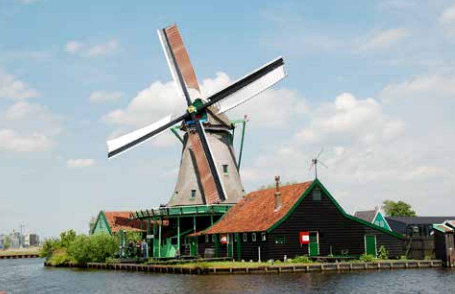
De Bonte Hen aan de Zaanse Schans, in 1975 gecompleteerd tot werkende oliemolen en – ter geruststelling van veel molenliefhebbers – niet tot kantoor of museum (foto Harmannus Noot, 2010)
