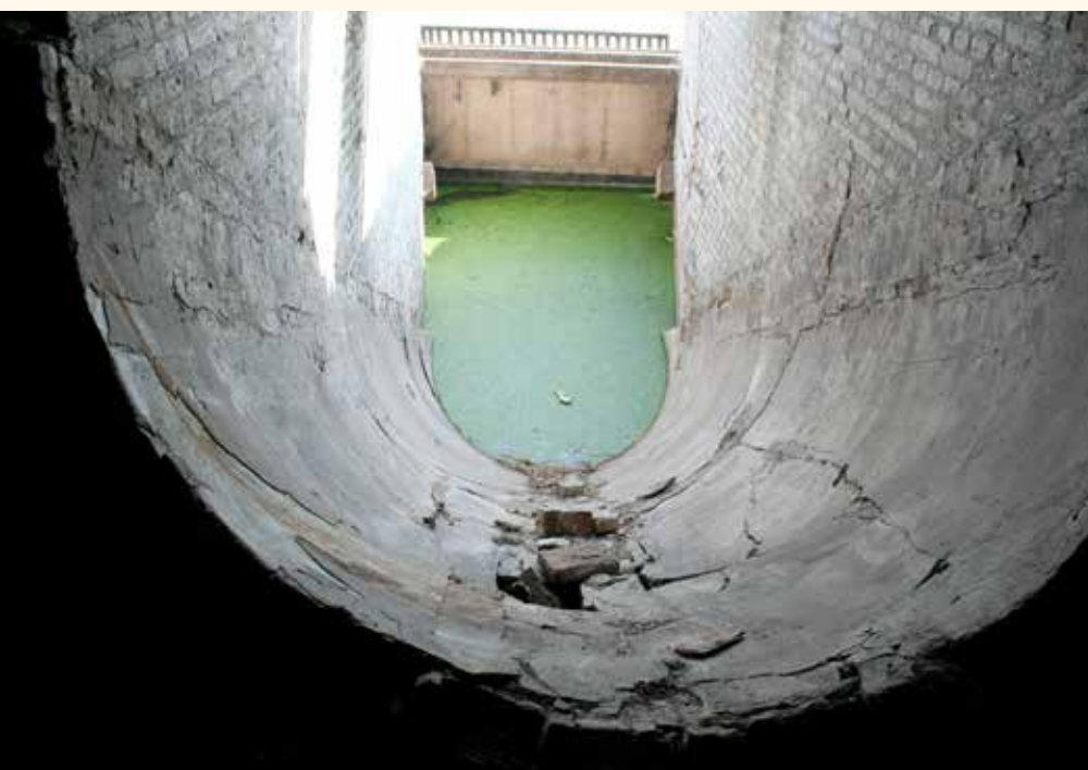
Gescheurde vijzelkom (foto Jos van Schoten, 4 oktober 2014).
