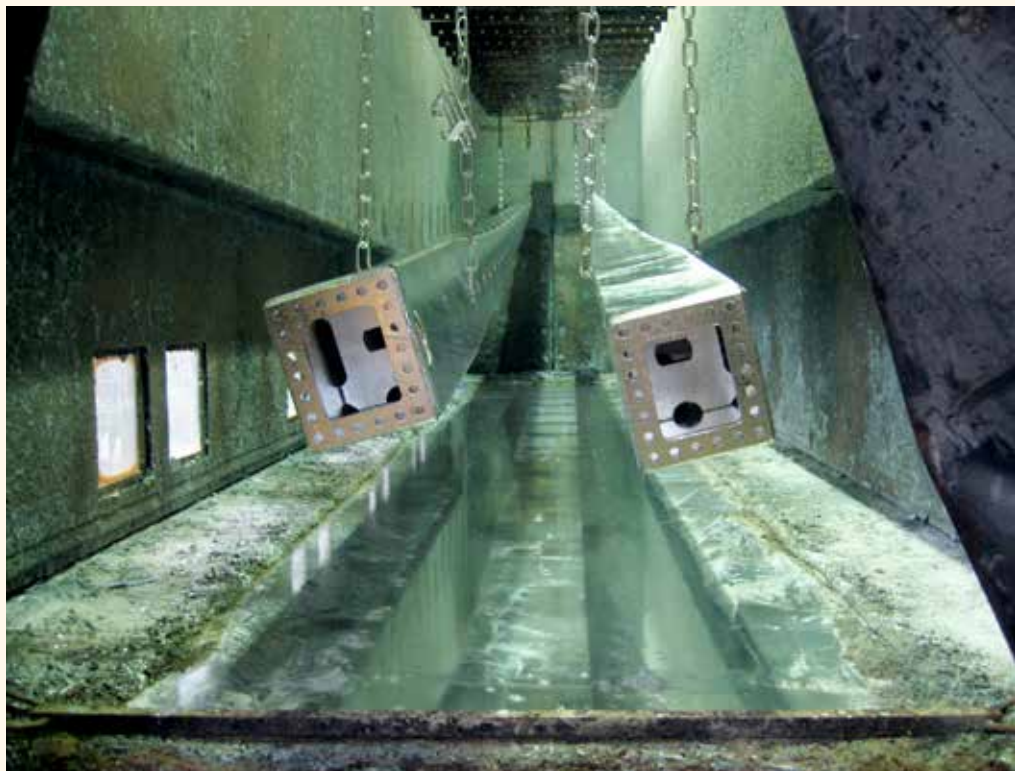
De twee enden van een deelbare roede worden thermisch verzinkt door ze te dompelen in vloeibaar zink van 450 graden Celsius. Het gaat hier om de allereerste roede, het prototype, waarbij het nog de vraag was of de roede krom zou trekken of niet. Dat gebeurde niet, en deze roede en een tweede werden gestoken in Birdaard, in molen De Olifant. Het verzinken vond plaats bij het bedrijf Coatinc (voorheen Nedcoat) in Alblasserdam in oktober 2007 (foto Gerard Troost - RCE).
