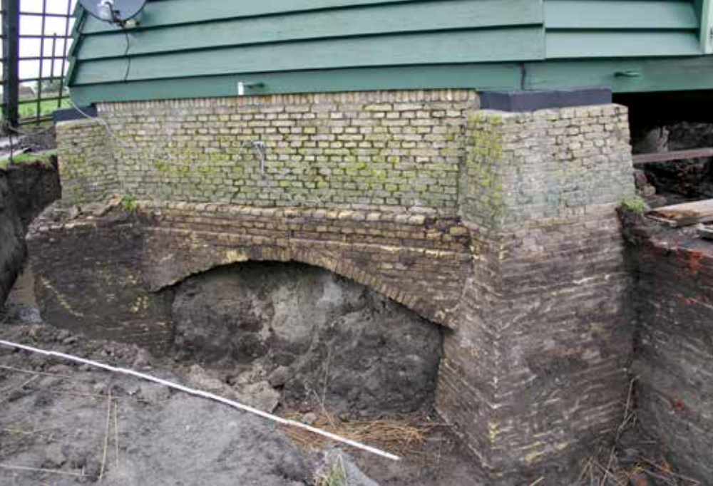
De rechter penant tegen de vijzelmuur wordt naar onderen steeds breder en wijkt daarmee af van de oude penanten. In de schepradtijd zal er geen veldmuur in dit valse veld hebben gezeten. Bij het vervijzelen heeft men deze oude waterlopen dichtgegooid en hierover bogen gemetseld met daarop normale veldmuren (foto 7 oktober 2014).
