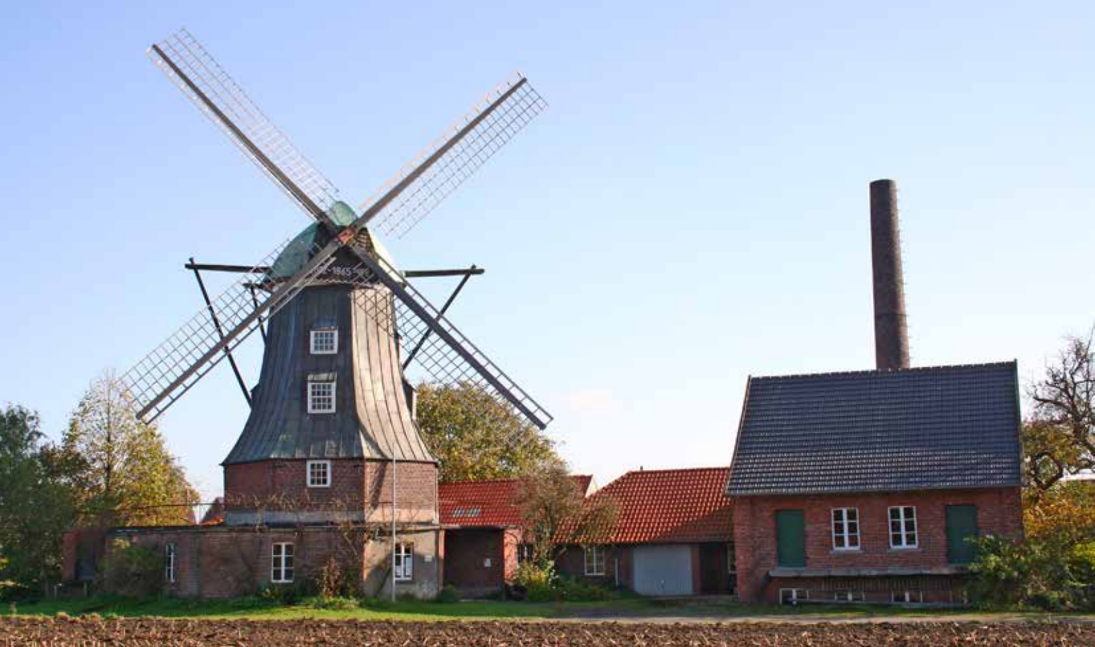
Mühle Menke in Südlohn, net over de grens bij Winterswijk. Ogenschijnlijk een oninteressante, louter optisch gerestaureerde molen; een bovenwiel ontbreekt, dus draaien kan hij niet, maar... molen en bijgebouwen herbergen een complete maalderij en zaaginrichting aangedreven door twee Herforder dieselmotoren. Ook zijn er nog restanten van de oude stoominrichting aanwezig. Op de Deutscher Mühlentag is alles in bedrijf te zien. Restauratie tot maalvaardige molen zou dit alles vernietigen (foto Ronald Bakker, 2008).
