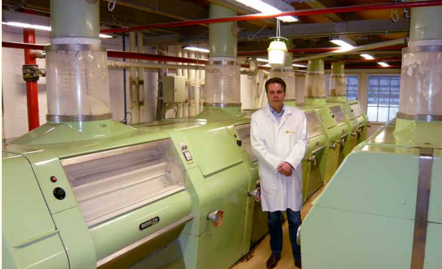
Huidig directeur Frank Vogelzang op de walsenzolder van de fabriek. Hier staan 13 walsenstoelen opgesteld, ieder met een dubbel stel walsen.
