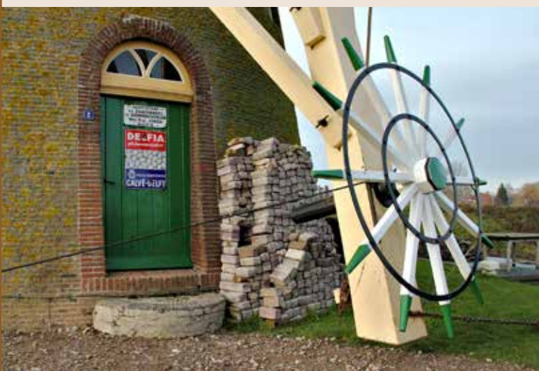
Reeds voor de wijziging van de kleurstelling keerden de originele reclameborden op de molen terug na zestig jaar afwezigheid. Geheel rechts is nog het dak van de machinekamer te zien, die half in de dijk is gebouwd.
