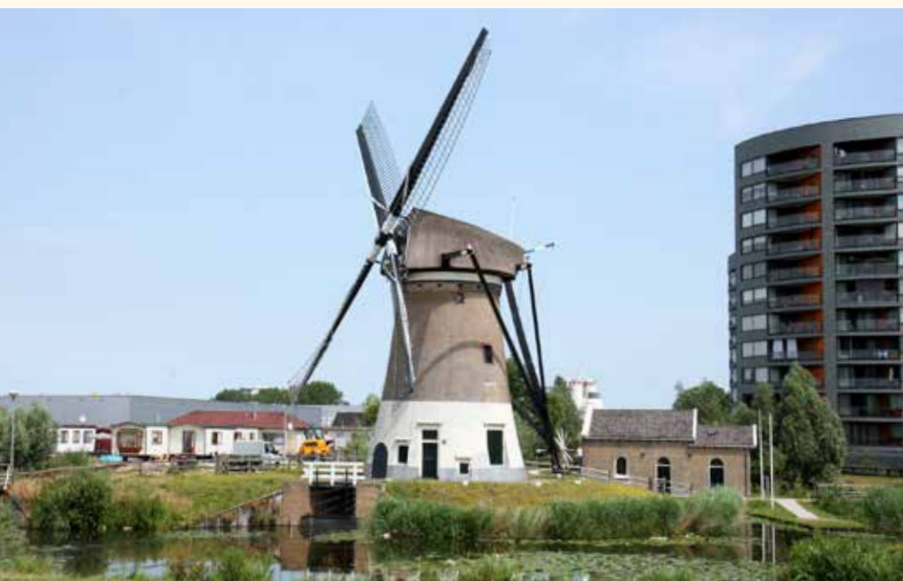
De Mallemolen in Gouda: na ruim 100 jaar onttakeld te zijn geweest en lang als machinistenwoning te hebben gediend, vond in 2009-2010 de restauratie plaats. Bazelmans voorzag in zijn essay een ahistorisch ensemble ontstaan van een maalvaardige molen en een werkende zuiggasmotor. Die motor in het gemaal rechts op de foto werd helaas uitgesloopt; niet echt een troost... (foto Ronald Bakker, 2015).
