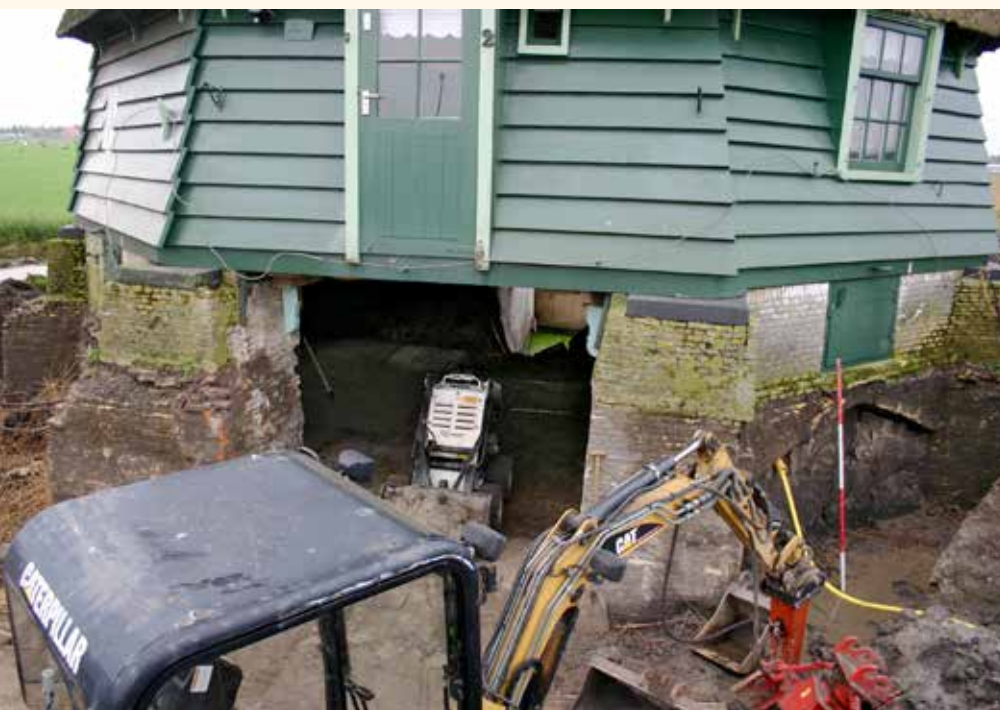
De molen tijdens de werkzaamheden in oktober 2014. Te zien is dat de rechter penant veel slanker is dan de linker. Deze penant moet zijn aangebracht tijdens de vervijzeling. In de schepradtijd ontbrak niet alleen het metselwerk in het rechter valse veld, maar ook het tafelementstuk. De stijlen aan weerszijden van de voorwa- terloop werden op dergelijke molens altijd gekoppeld door een zware regel, die hier net boven het raam zit.
