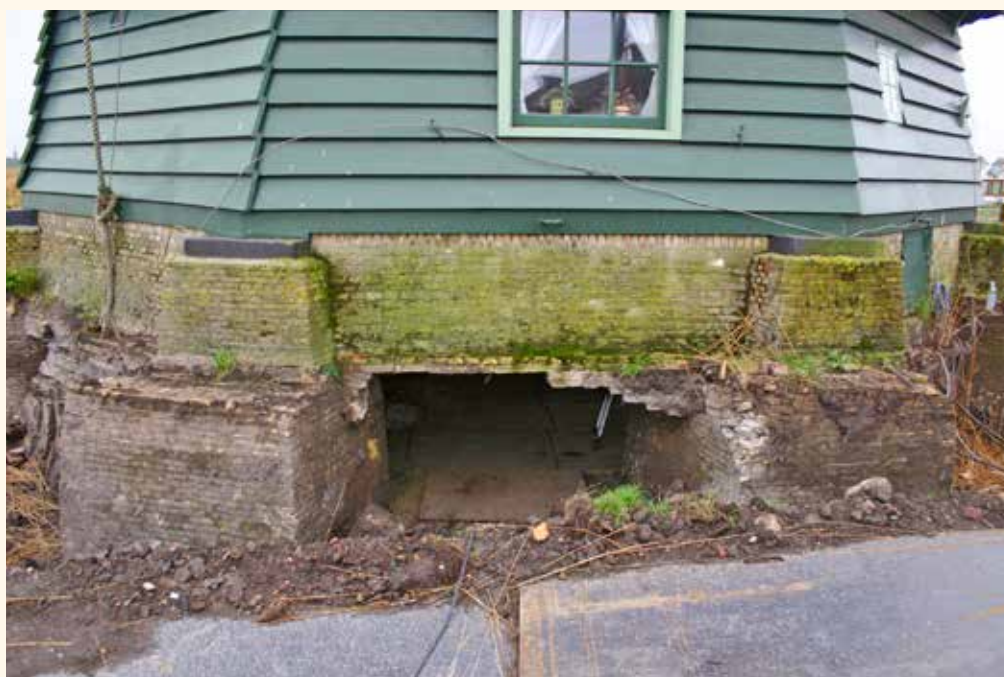
Noordoostzijde van de molen op 7 oktober 2014. Te zien is dat de oude penanten een flink stuk uitsteken en dat de veldmuren nauwelijks een fundering hebben.
