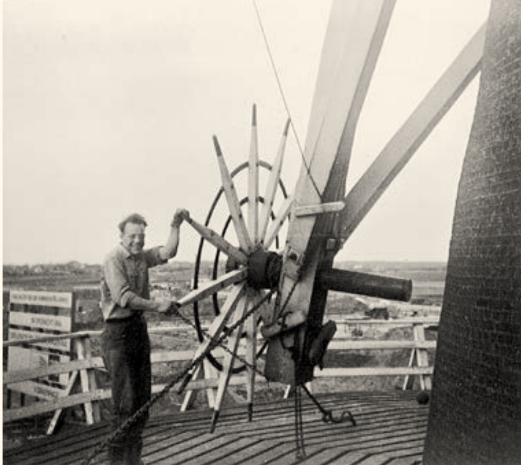
Krien als zelfstandig molenaar op de molen Ons Genoegen in Middelburg, gefotografeerd in het voorjaar van 1964. De molen is weer maalvaardig gerestaureerd en voorzien van een kruirad. Op de achtergrond is gestart met de bouw van woningen tegenover de molen. Na de brand in augustus 1964 werden hier stempels gehaald om de stelling te stutten. De as was door de windpeluw gezakt als gevolg van de brand. Het gevluht rustte nu op de stelling.
