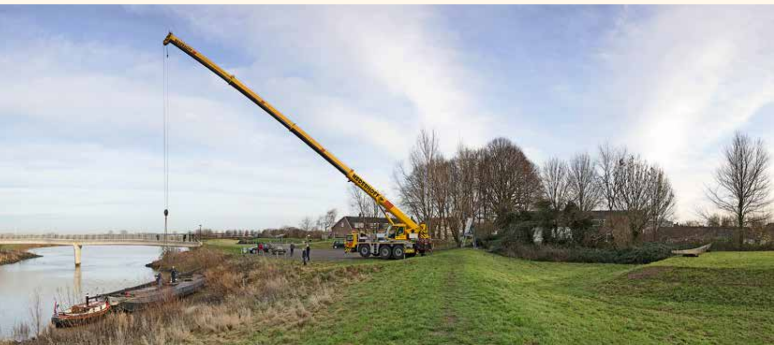
De molenroeden die ter beschikking zijn gesteld arriveren per dekschuit over de rivier de Lek bij de locatie waar de molen wordt gebouwd. Rechts zien we de al klaargemaakte molenberg (foto door Fotostudio Marks, Vianen).
