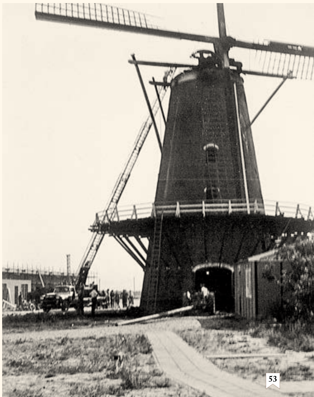
► De stellingmolen Ons Genoegen te Middelburg daags na de fatale brand in 1964. Het hekwerk van het bovenste end is volledig weggebrand, alsmede een groot deel van het bovenwiel.
