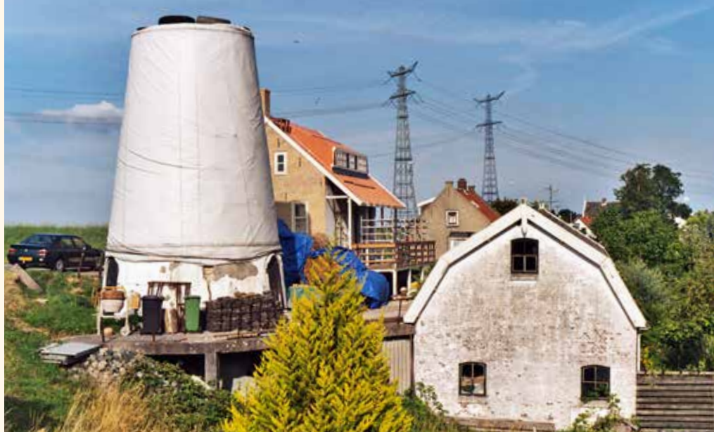
Restauratie-compromis: korenmolen De Regt in Nieuw-Lekkerland werd recent weer als werkende (draaiende) windmolen gecompleteerd, maar bleef inwendig maalvaardig als motormaalderij (foto Harmannus Noot, 2003).
