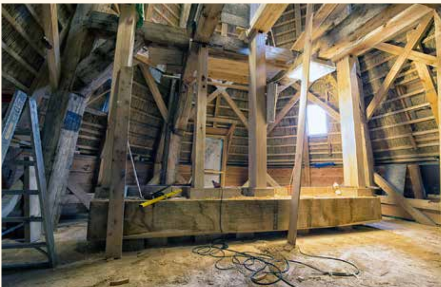
De hennepklopinstallatie van De Paauw in aanbouw (foto Alfons van Schijndel).
