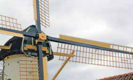
Het nieuwe gevluicht, voorzien van de oude kleuren. De maatvoering van de borden komt nog uit de jaren '50. De hekkens zijn breed, maar de zeeg is vrij vlak. Het zal dan ook een vlugge molen zijn geweest (foto Jesse in 't Veld, 5 april 2018).
