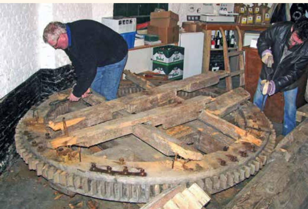
Molen De Vlijt in Meppel. Demontage van het spoorwiel (foto Kees Vanger).
