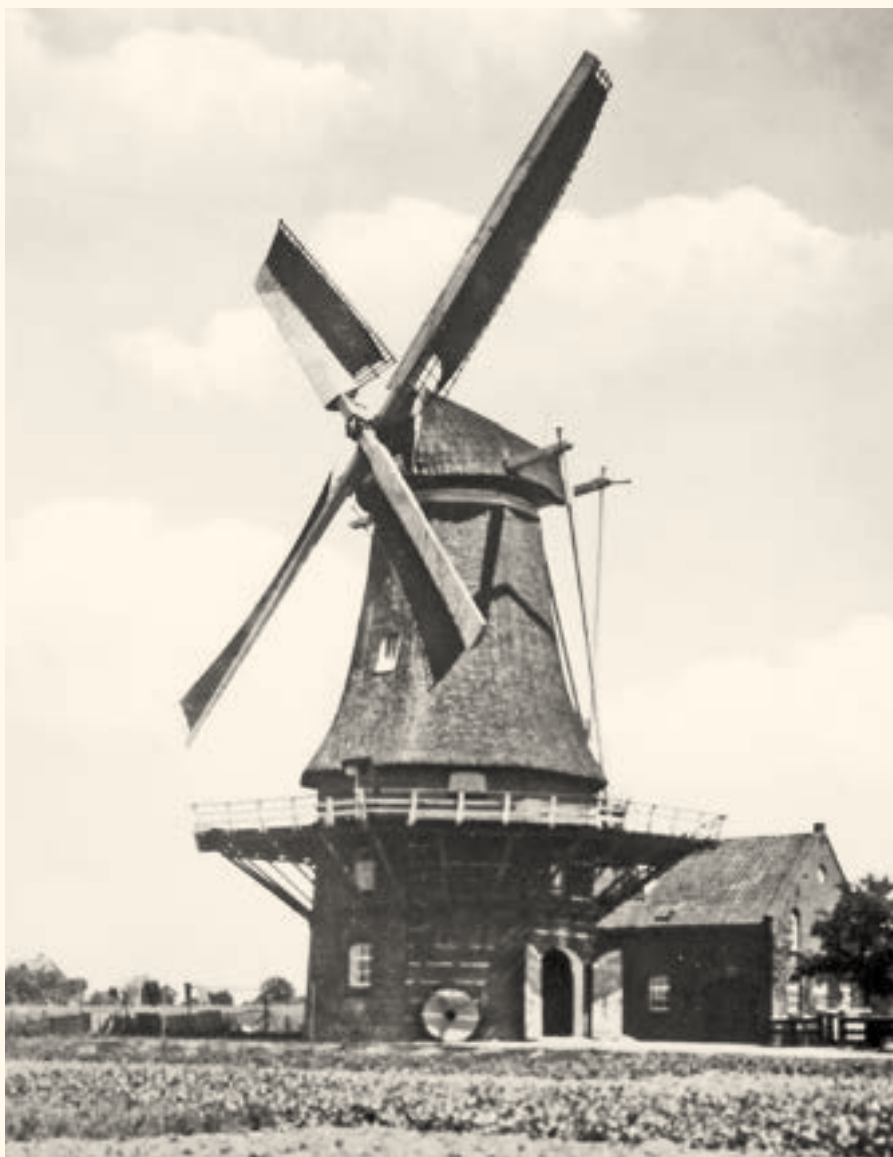
De mölle van Dieperink in volle actie met een verdekerde buitenroe. Foto van W. Voerman, abusievelijk gedateerd in 1972. In 1948 werden Ten-Havekleppen aangebracht. Deze foto dateert waarschijnlijk van kort na de Tweede Wereldoorlog. Opvallend is de diepe zeeg die kennelijk ook in combinatie met verdekking voorkwam (collectie Vereniging De Hollandsche Molen).
