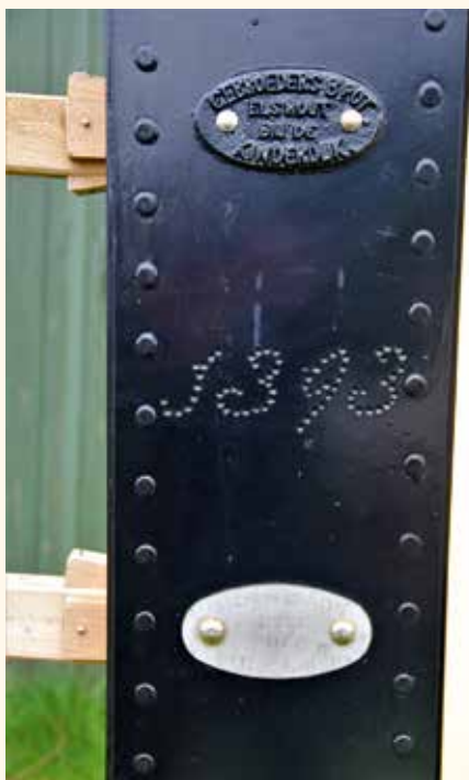
Close-up van Potroede 1393 met het nieuwe plaatje van Vaags. Deze roede werd in 1883 nieuw geleverd voor molen Landzicht in Numansdorp en tijdens de eerste restauratie in de zestiger jaren hier geplaatst (foto Jesse in 't Veld, 5 april 2018).
