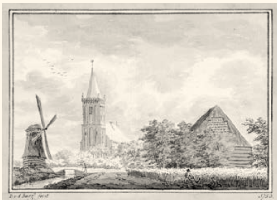
11. Gezicht op Hoogwoud anno 1753 door D. van de Burg. Korenmolen De Lastdrager is hier duidelijk nog afgebeeld als binnenkruier.
