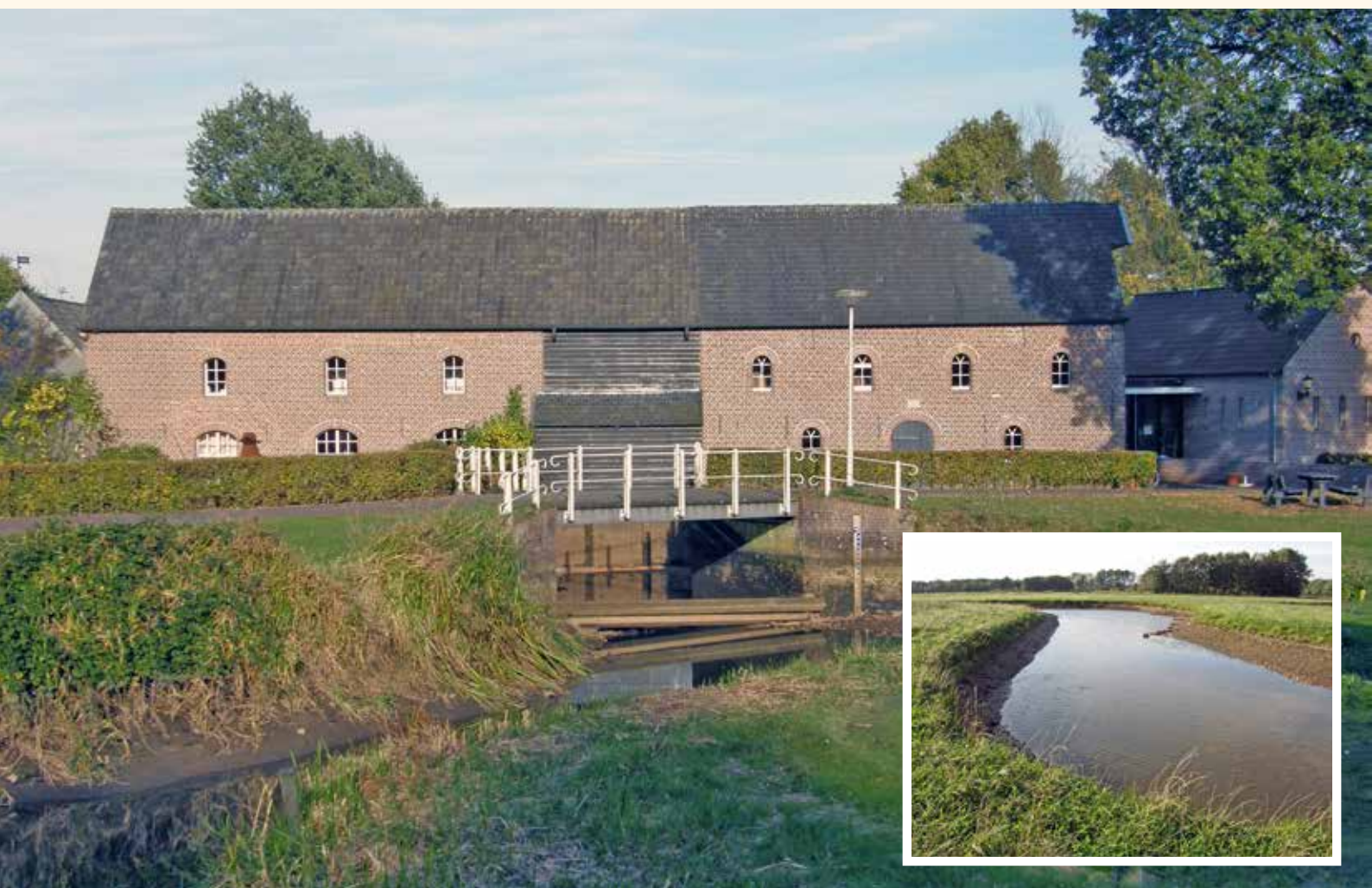
4. Voorbeeld van het effect van de stuwschaduw bij de Spoordonkse molen (NB). Tijdens restauratiewerkzaamheden in 2008 werd het molenpeil tijdelijk met 1.4 m verlaagd. Ongeveer 1 kilometer stroomopwaarts van de molen (foto inzet) was als gevolg daarvan nog altijd sprake van een verlaging van het beekpeil met ongeveer een meter.
