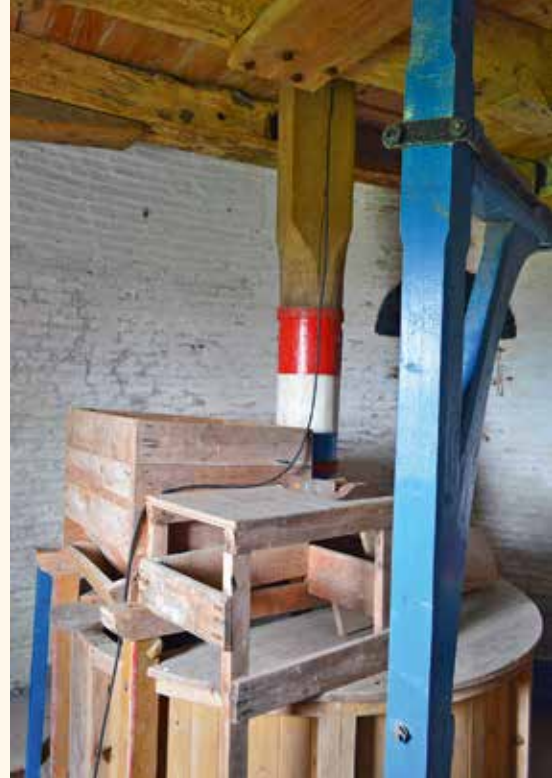
Op de steenzolder ligt nog één koppel 15der kunststenen. Het bont geschilderde houtwerk geeft het interieur een frisse aanblik. De bintlaag van de luiszolder is gemaakt uit tweedehands eikenhout, waarschijnlijk van de voorganger. Dendrochronologisch onderzoek zal in de toekomst uit kunnen wijzen of dit daadwerkelijk zo is (foto Pieter Dorst, 29 juli 2016).
