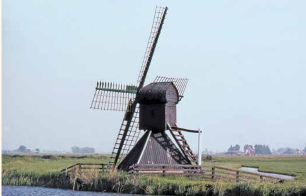
13. De spinnekop van de polder Wieuwens bij Oosterlittens is bekend vanwege de grote stapeling van de bovenas, nodig om het wiekenkruis vrij te laten draaien van het wijde onderhuis. Dit onderhuis blijkt al rond 1690 gebouwd te zijn (collectie Vereniging De Hollandsche Molen).
