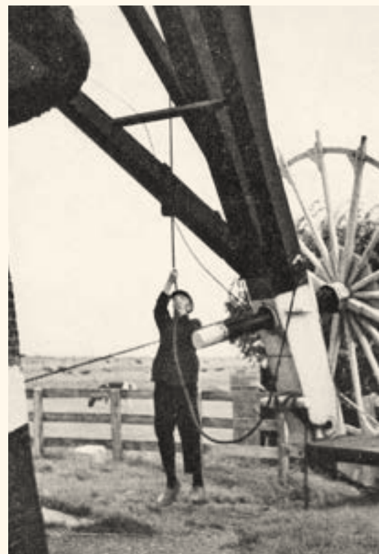
Poldermolenaar Dirk van Harten van de Droog-gemaakte Polder aan de Westzijde van Aarlander-veen hangt met zijn volle gewicht aan het vang-touw om zo de vang te kunnen lichten (foto G. van der Mark, 1943).
