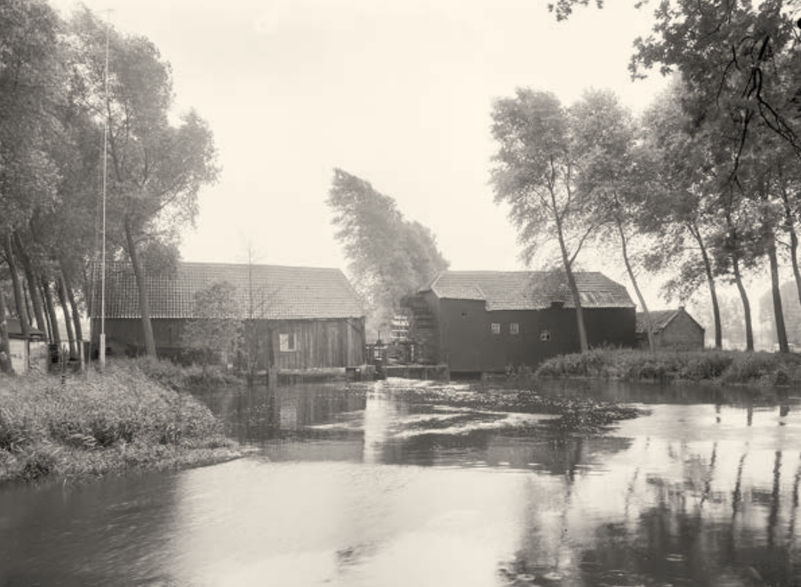
2. De Collse watermolen in Eindhoven in 1966. Dat de cultuurhistorische en landschappelijke waarden van een watermolen veel verder reiken dan het gebouw zelf, en niet alleen boven de molen waar de opstuwing van het water plaatsvindt maar ook beneden de molen, dat maakt deze foto op indrukwekkende wijze duidelijk (foto G. J. Dukker, collectie Rijksdienst voor het Cultureel Erfgoed, objectnummer 107.127).
