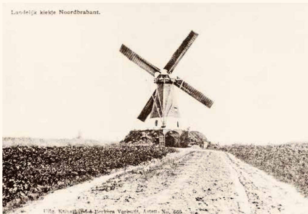
De pas gebouwde molen in een maagdelijk landschap. De Ansichtkaart moet uit de periode 1907 – 1909 dateren. De lange spruit is relatief kort, wat erop wijst erop dat deze balk vlak na de overbrenging van de molen uit Groningen nog in het midden van de kap lag (collectie Vereniging De Hollandsche Molen).
