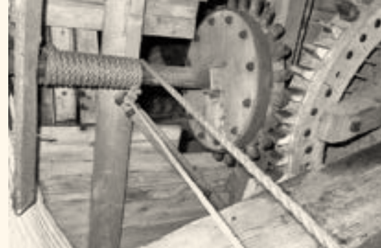
Een uniek element in de molen is het kammenluiswerk, dat werkt op het spoorwiel. Deze uitvoering komt waarschijnlijk nergens anders voor (collectie Vereniging De Hollandsche Molen).
