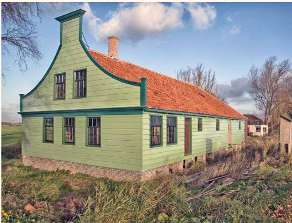
De molenshuur na restauratie (foto Alfons van Schijndel).
