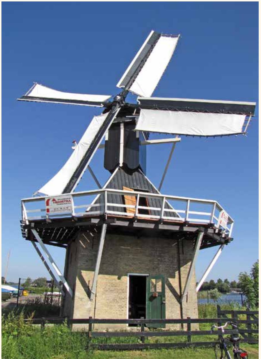
15. De Groene Molen kan na de laatste restauratie zowel op de motor als op windkracht water malen. De hoekstijlen van de molen blijken uit in 1696 gekapte eiken te komen. De huidige molen moet daarom zeker als grondzeiler zijn gebouwd (foto Van Reeuwijk bouwmeester).
