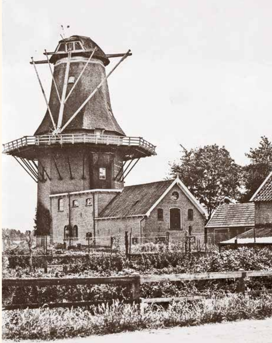
◀ De mōlle van Stormink in Twello. Vóór het verwijderen van het gevluht in 1926 waren beide roeden voorzien van zelfzwichting. Achter aan de kap is het bedieningsmechanisme van de kleppen nog aanwezig (collectie Vereniging De Hollandsche Molen).
