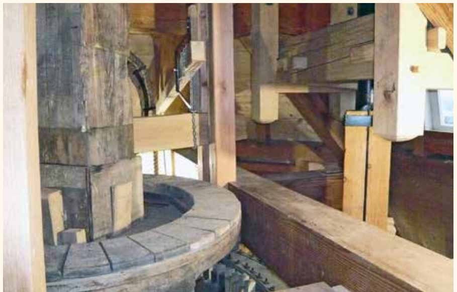
Bij de verplaatsing van de molen vanuit Groningen werden de molenstenen op een ander niveau geplaatst. Om dat mogelijk te maken werd de onderste bintlaag hoger in de molen gelegd, waardoor die bintlaag en de tweede erg dicht bij elkaar kwamen te liggen. Deze merkwaardige constructie is in de herbouwde molen teruggekomen. Op de foto vallen de bint- of legeringsbalken van douglashout op door hun roodbruine kleur (foto Jan Scheirs).
