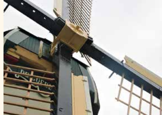
Close-up van de in de tekst aangehaalde ijzeren zeilarmen. Een unicum in de streek en wellicht daarbuiten (foto Jesse in 't Veld, 5 april 2018).
