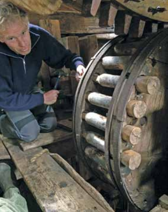
Om onbelast te kunnen draaien neemt Roel de schietstaven uit het rondsel (foto Robert-Jan Prins, 19 mei 2017).
