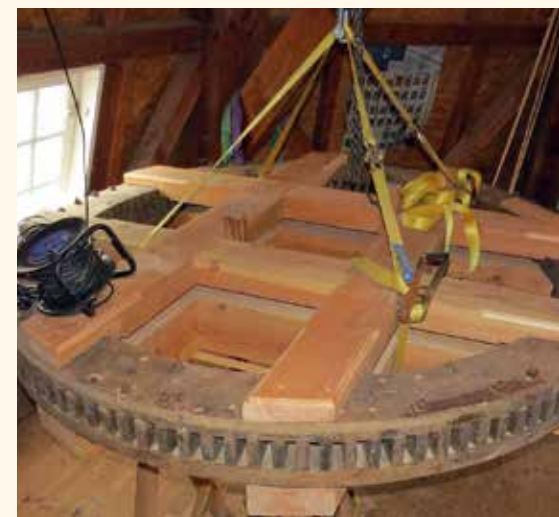
Molen De Vlijt in Meppel. Het spoorwiel bijna klaar voor montage (foto Kees Vanger).
