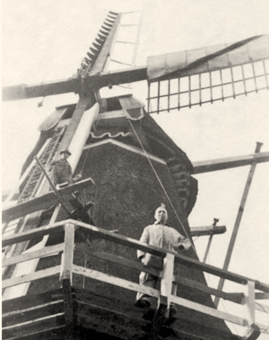
Actiefoto genomen in 1948 tijdens het vervangen van de binnenroe die meteen Ten-Havekleppen kreeg. Ten Have combineerde zijn remkleppen in het begin wel met een verdekking op de andere roe (al dan niet al aanwezig), zoals bij De Bataaf in Winterswijk, in Oudorp, Terwolde en in Warnsveld ook. Een diepe hekstand op de roe die dan verdekkerd is, levert trekkracht die de beperkte breedte van de kleppen compenseert (collectie André Nibbelink).
