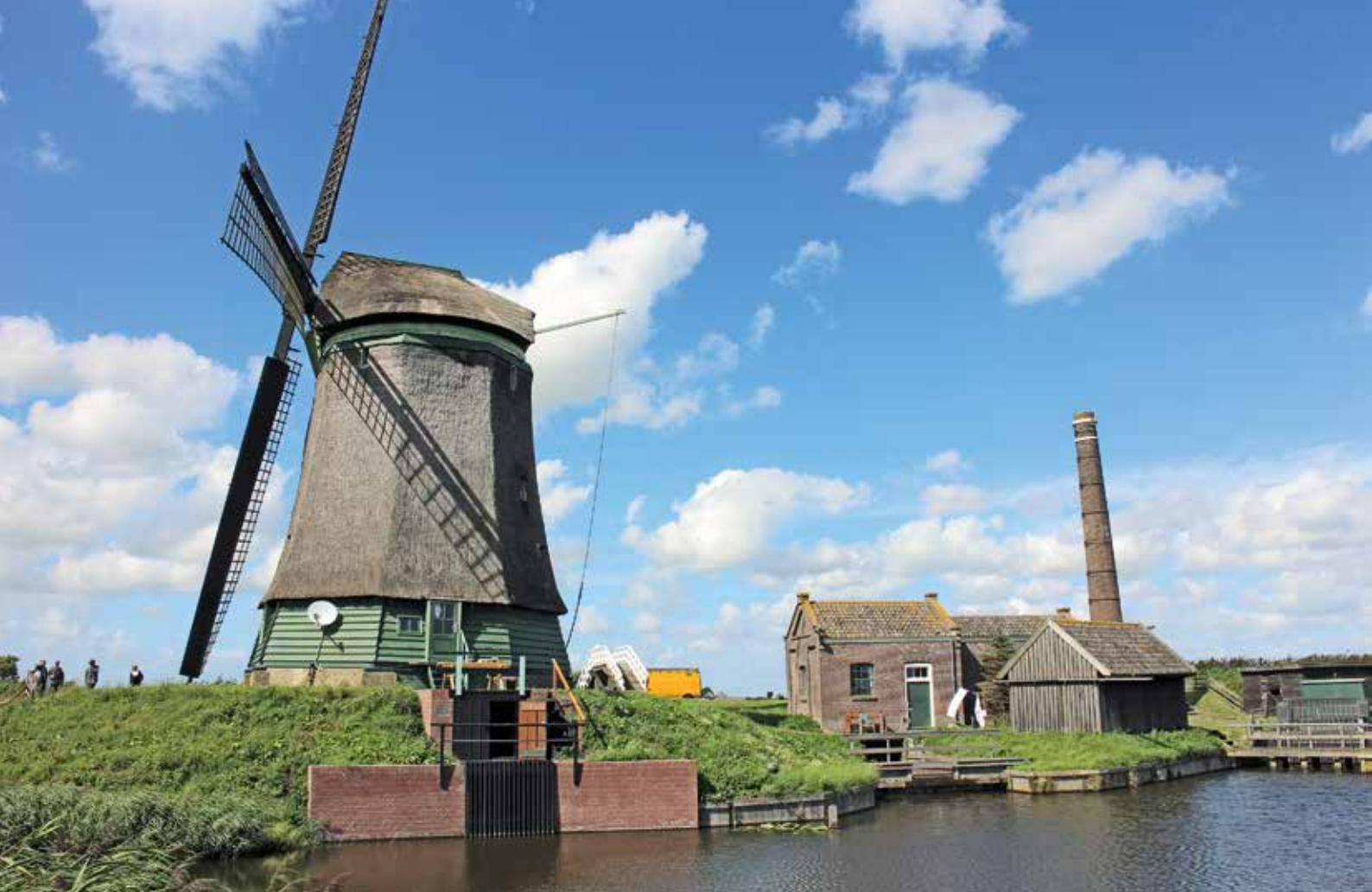
3. Drie generaties bemalingswerktuigen naast elkaar bij Opmeer: de in 1654 als schepradmolen gebouwde Kaagmolen, het in 1879 gebouwde hulpstoomgemaal uitgerust met een centrifugaalpomp, en helemaal rechts het volautomatische vijzelgemaal (foto Van Reeuwijk bouwmeester).
