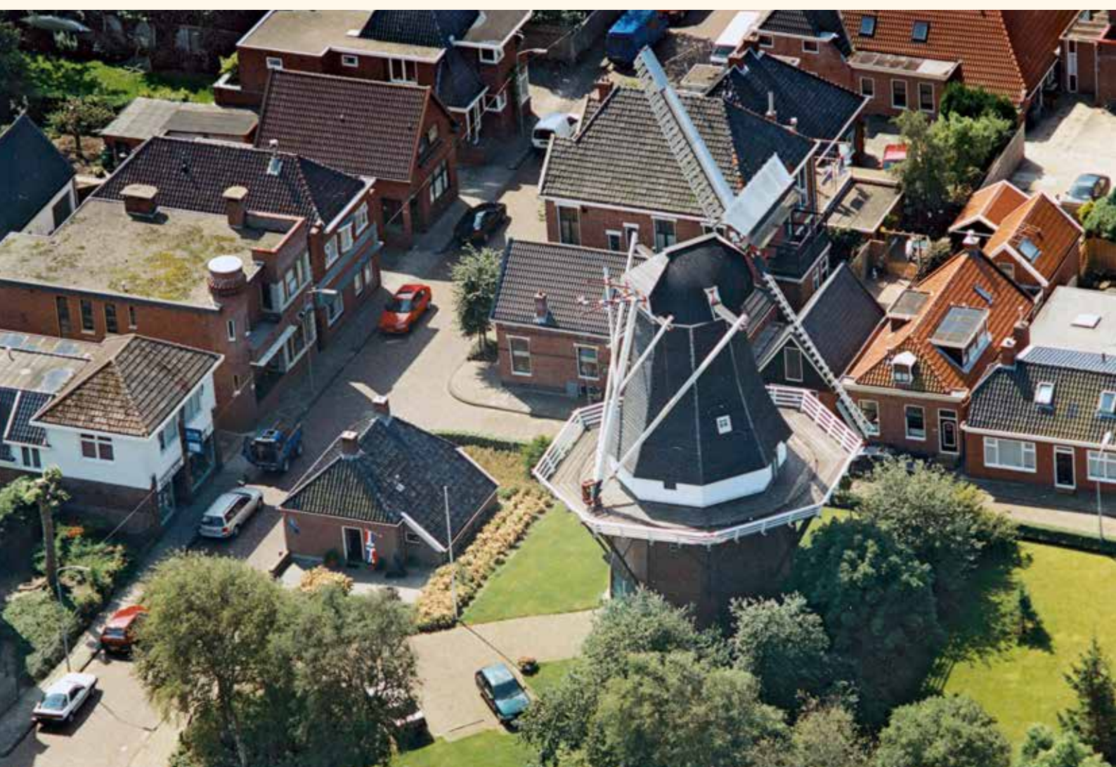
De foto toont de koren- en pelmolen "De Liefde" te Uithuizen, gebouwd in 1866, na afbraak van de standerdmolen, waarvan een eerste vermelding is van 1499. Rechts in de hoek is nog net de gevel van het oude molenaarshuis te zien. Direct links van de molen staat de sarrieshut, waarvan een eerste voorganger gebouwd werd in 1630. In die tijd stond de molen nog ten westen van het dorp (foto collectie auteur).
