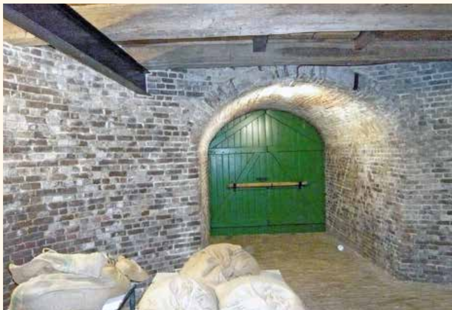
De molen had altijd maar één inrit. Deze is afgesloten met nieuwe deuren die geconstrueerd zijn zoals het betaamt en die op de oude wijze worden gesloten (foto Jan Scheirs).
