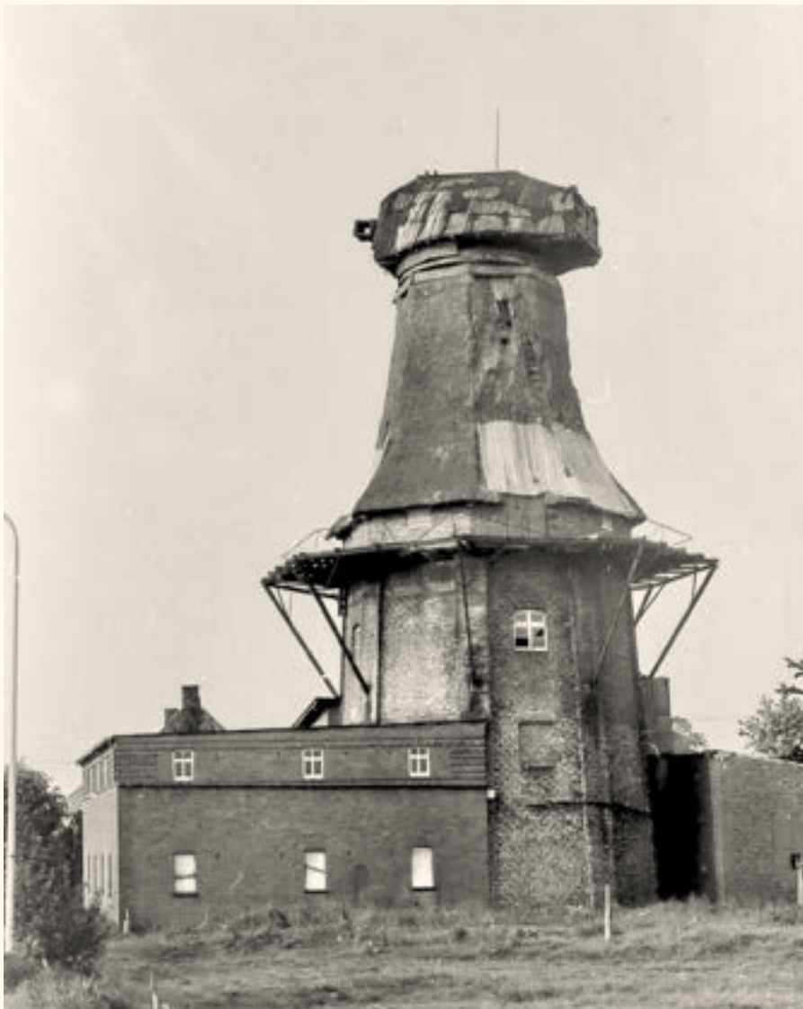
Mühle Friesenborg, Marienhaf. Op de ver naar achteren uitgebouwde kap was een windroos geplaatst waarvan op de foto nog sporen te zien zijn. Ook nu is er een windroos. Opname uit 1961 door G. Ottevanger (collectie Vereniging De Hollandsche Molen).
