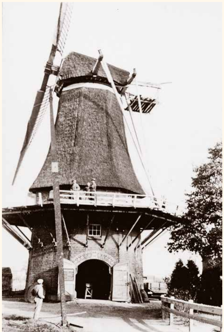
Het steken van een nieuwe roede in een voorganger van de huidige molen op de Wiek (buurtschap De Wijk) in Terwolde in 1948. Het steigertje achterop de kap droeg de installatie waarmee de as werd doorboord (collectie André Nibbelink).
