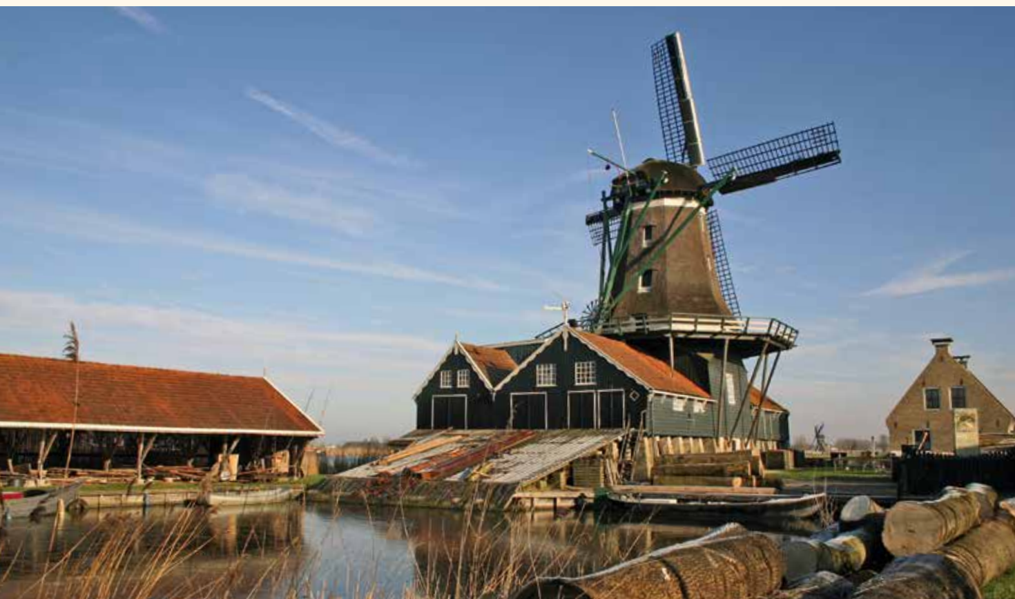
16. Het jaarringenonderzoek levert ook geregeld minder oude dateringen op. Bekend was dat houtzaagmolen De Rat te IJlst afkomstig was uit Westzaandam en hij zou daar al voor 1683 zijn gebouwd. Het bouwjaar blijkt echter 1711 te zijn (foto Jan Hofstra).
