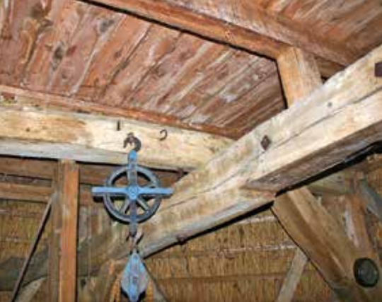
10. Bovenste legering van molen De Lastdrager te Hoogwoud. Duidelijk is te zien dat er flink wat ruimte zit tussen de kruisende bintbalken (foto Van Reeuwijk bouwmeester).
