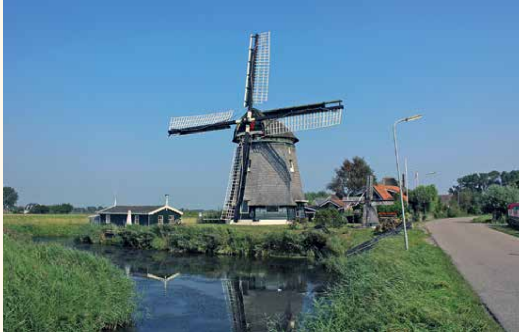
12. De Groenveldermolen van de polder Valkoog te Sint Maarten. De bomen waaruit het achtkant is gemaakt, blijken in 1525 al gekapt te zijn (foto Van Reeuwijk bouwmeester).
