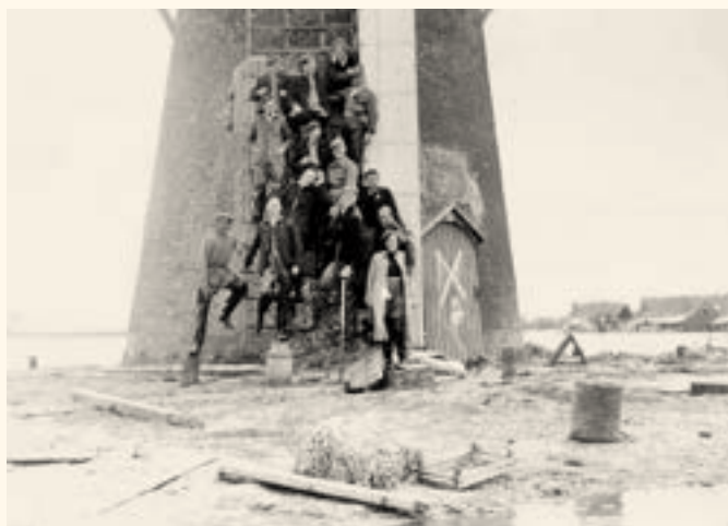
Op deze foto van de Oosterlandse molen, die maanden na de ramp werd genomen, is een groep mensen te zien, die bezig waren om in het dorp op te ruimen. Het witte kruis op de molendeur is een teken dat de molen is doorzocht op slachtoffers.
