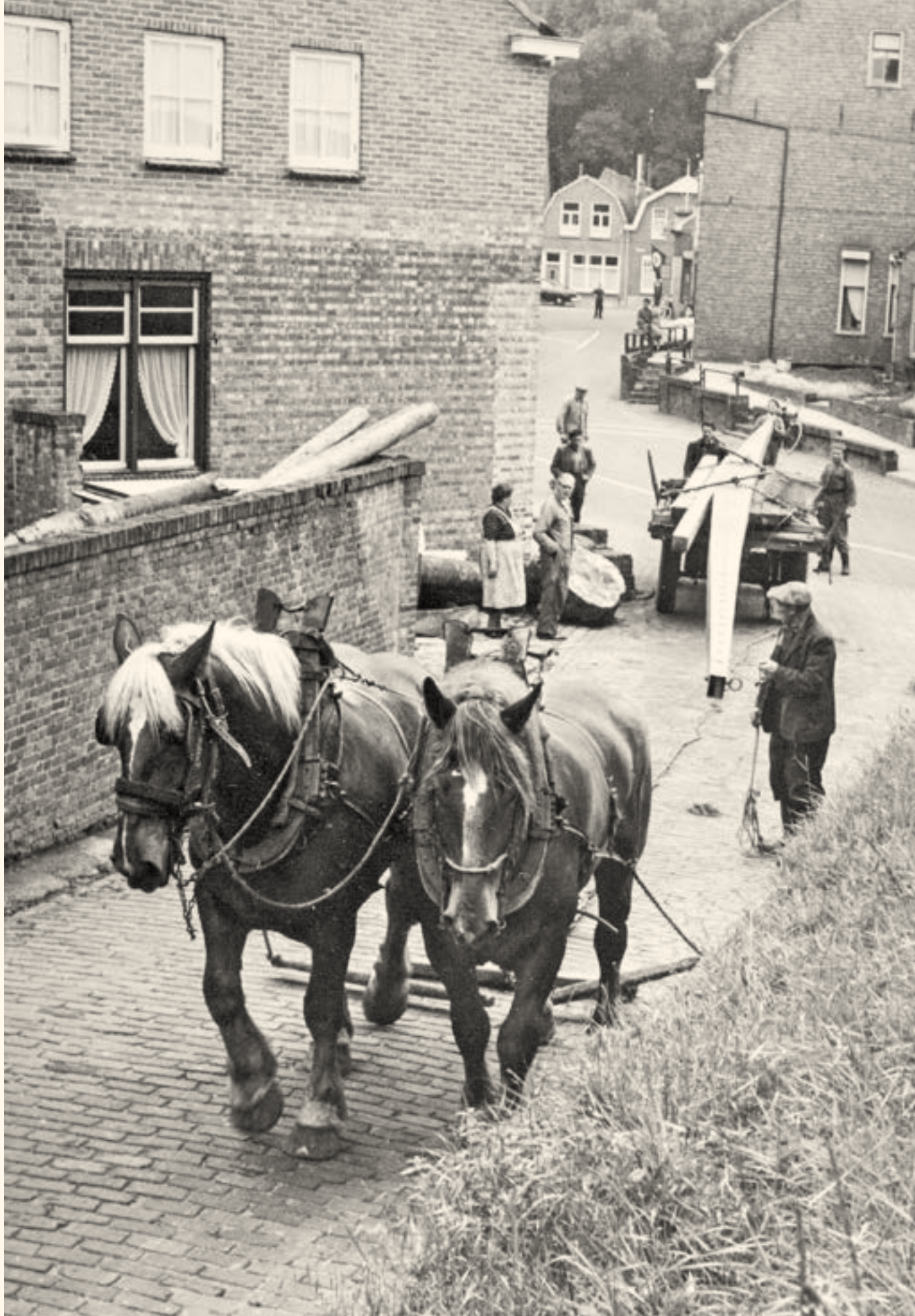
Bij groot herstel aan de molen van Hulst door de firma Bos in 1956 werden de nieuwe roeden (fabricaat Bremer) aangevoerd over het water, opgehaald aan de loswal in Walsoorden en op twee platte wagens over een afstand van zo'n 15 km vervoerd naar de stad. Op deze foto zien we het transport van de binnenroe en de twee lange schoren. Rien Bos herinnert zich nog hoe de paarden, die getraind waren om in het bos boomstammen te verslepen en daarbij obstakels te vermijden, zich heel precies lieten aansturen door de voerman rechts op de foto. Achteraan zien we de drie molenmakers: de jonge Rien Bos (toen ook al met alpinopet) bij het achtereind van de roe, Jan Haspels jr. links achter de wagen, en Jan Bos in de lichte kledij staand geheel links (foto Neelemans, Hulst; reproductie Jan Klerks).
