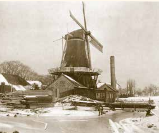
Het zaagmolencomplex van Wilte Evenhuis te Woltersum, gefotografeerd in 1928, met rechts de aanbouw voor de lintzaag en het gebouwtje met de pijp voor de stoommachine.
