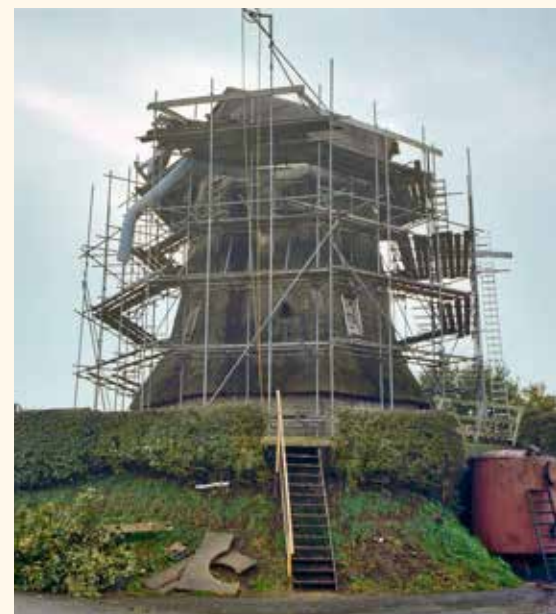
In 1980 onderging de molen wederom een restauratie. Met name kap en gevlucht werden onderhanden genomen. Na deze restauratie was de molen weer maalvaardig. Het werd de meest draaiende molen van Drenthe (foto 1980, W.A. Korpershoek, collectie Rijksdienst voor het Cultureel Erfgoed, objectnummer 222.823).
