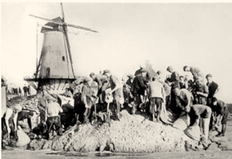
Rond molen "Den Haas" in Zierikzee werd een dijk aangelegd ter bescherming van de achterliggende stad.
