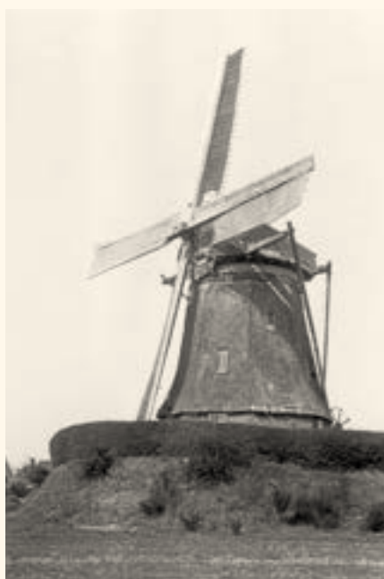
Deze foto zal in 1948 gemaakt zijn. Het gevlucht is inmiddels voorzien van het stroomlijnsysteem Van Bussel (collectie T. Meesters; Breda).
